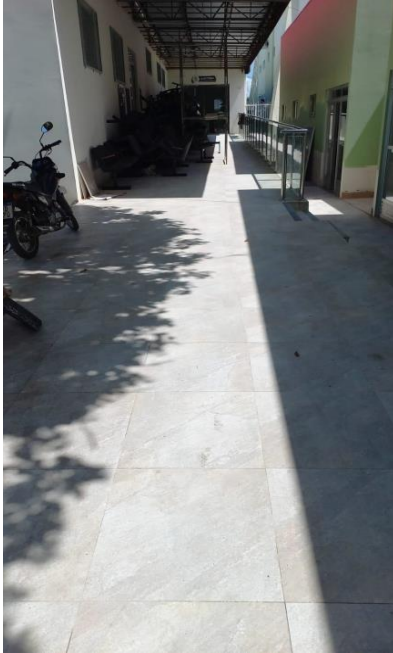
Imagem 07 – Rampa de acesso ao auditório.
