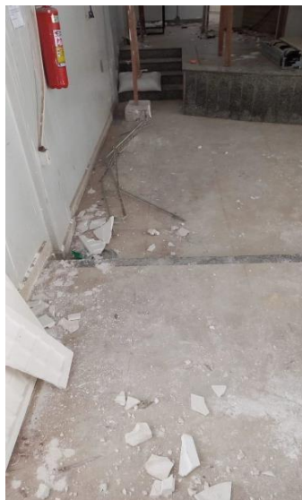
Imagem 11 – locação da rampa de acesso a plenária.
