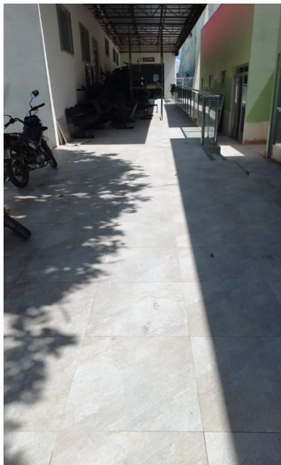
Imagem 07 – Rampa de acesso ao auditório.
