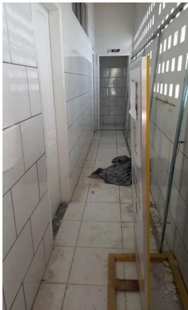
Imagem 09 – Acesso aos banheiros e copa do auditório.
