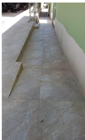
Imagem 06 – Acesso a rampa do auditório.
