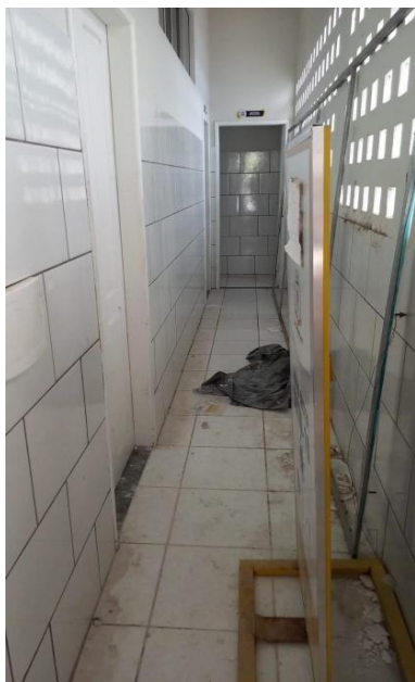
Imagem 09 – Acesso aos banheiros e copa do auditório.
