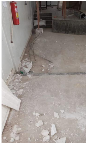
Imagem 11 – locação da rampa de acesso a plenária.
