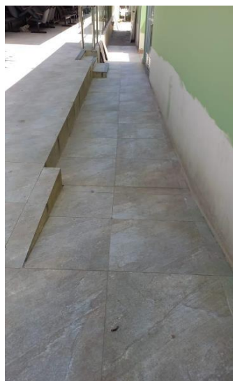
Imagem 06 – Acesso a rampa do auditório.
