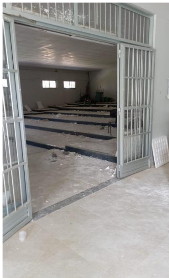
Imagem 10 – Porta de entrada do auditório.
