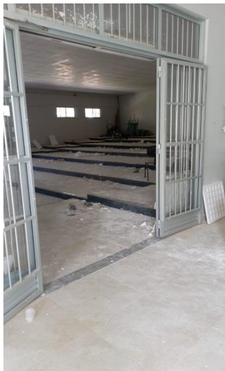
Imagem 10 – Porta de entrada do auditório.
