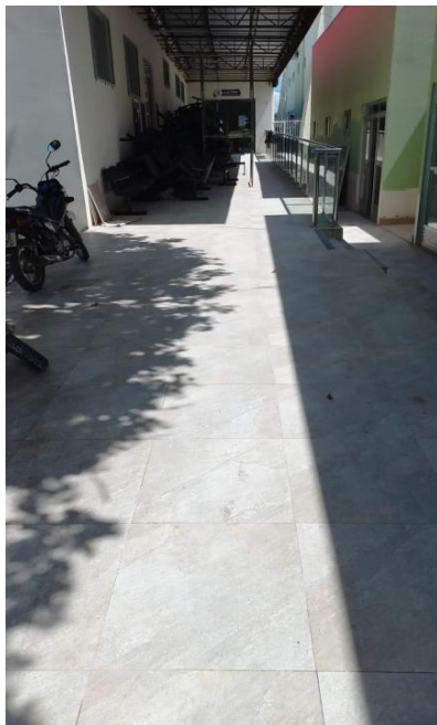
Imagem 07 – Rampa de acesso ao auditório.
