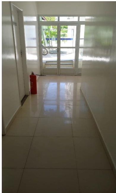
Imagem 05 – Corredor de acesso aos gabinetes com porta de saída para a rampa.
