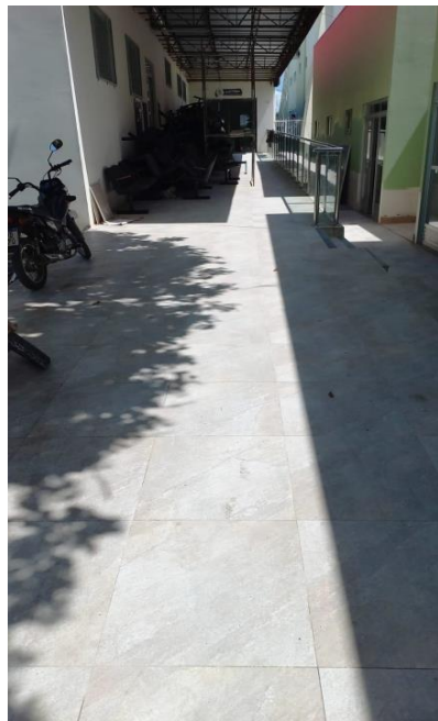
Imagem 07 – Rampa de acesso ao auditório.
