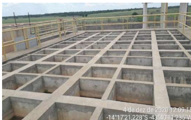
Figura 60 – Registro fotográfico do flocculador hidráulico
