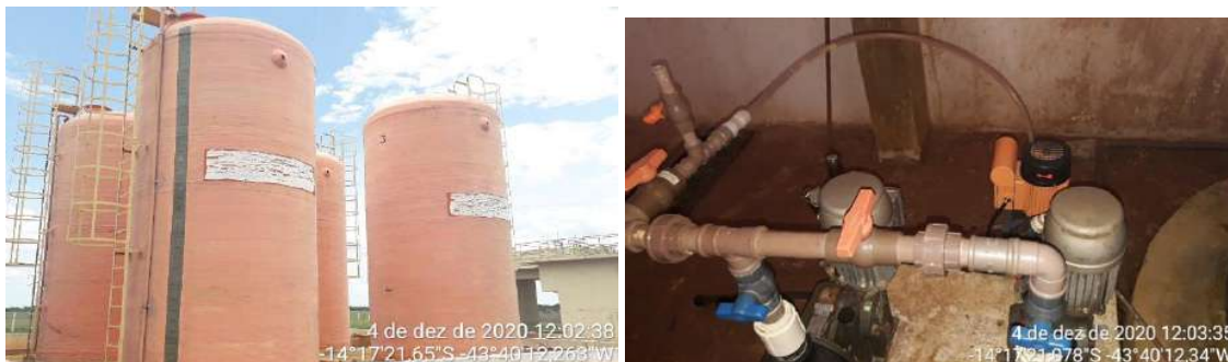
Figura 59 – Tanques de armazenamento do sulfato de alumínio e bomba dosadora de sulfato
