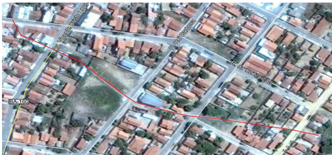
Figura 157 – Canal de Drenagem 02
