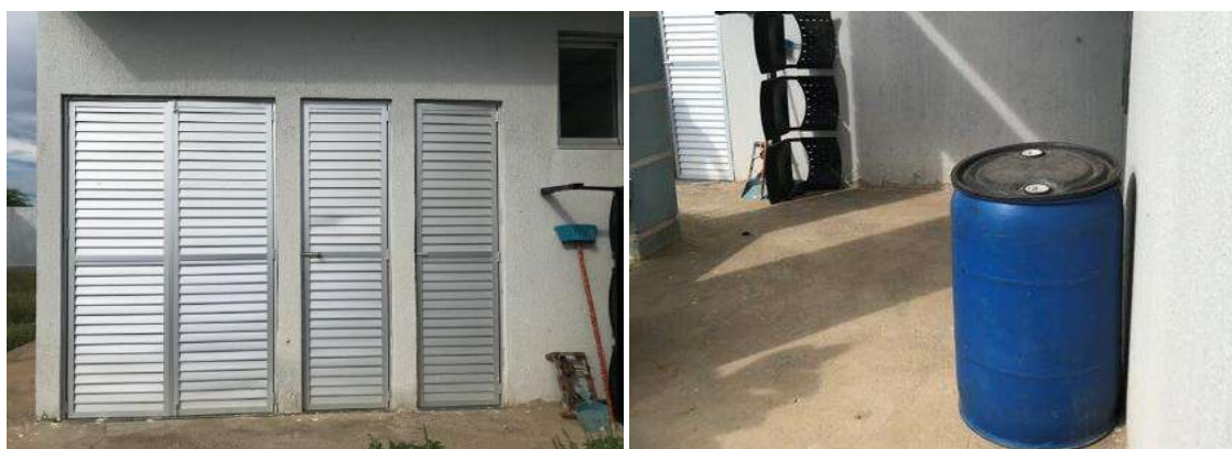
Figura 141 – Abrigo e bombona de armazenamento de RSS em unidade de saúde de Iuiu
