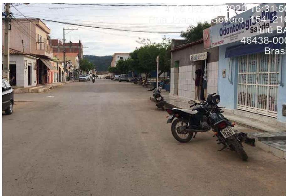
Figura 150 – Pavimentação do tipo asfáltica na rua Joaquim Severo
