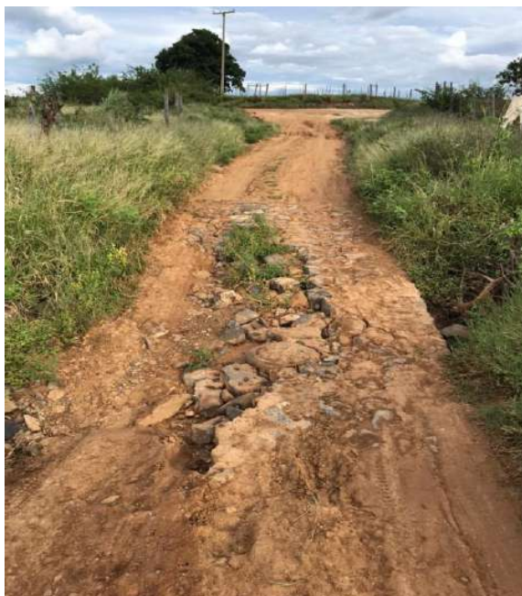
Figura 167 – Ponte na comunidade de Morrinhos
