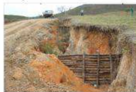
Paliçada de madeira
