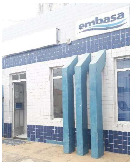
Figura 49 - Escritório local da Embasa na Sede de Iuiú
