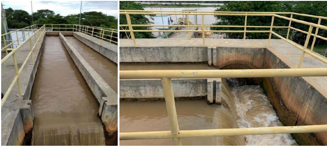
Figura 54 – Registros fotográficos do desarenador localizado na captação
