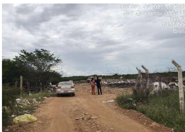
Figura 126 – Entrada do lixão sem portão e placa de identificação
