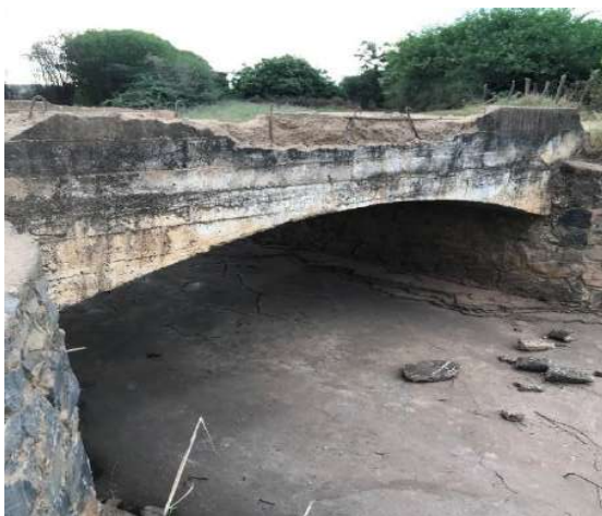
Figura 164 – Ponte em concreto a jusante do extravasor da barragem
