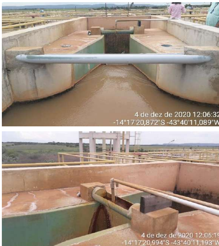
Figura 58 – Registros fotográficos da calha Parshall e do ponto de aplicação do sulfato de alumínio
