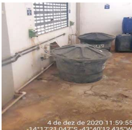
Figura 64 – Registro fotográfico do sistema dosador do ácido fluossilícico
