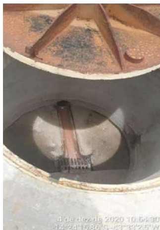
Figura 84 – Registros fotográficos do gradeamento existente nas estações elevatórias de esgotos
