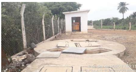
Figura 85 – Registros fotográficos da caixa de areia existente nas estações elevatórias de esgotos
