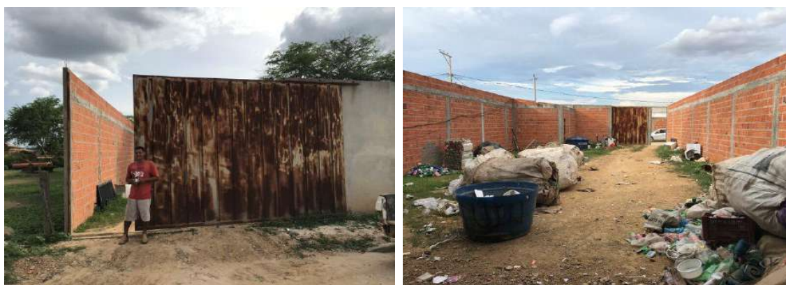
Figura 135 - Galpão para armazenamento temporário dos recicláveis coletados pelos catadores
