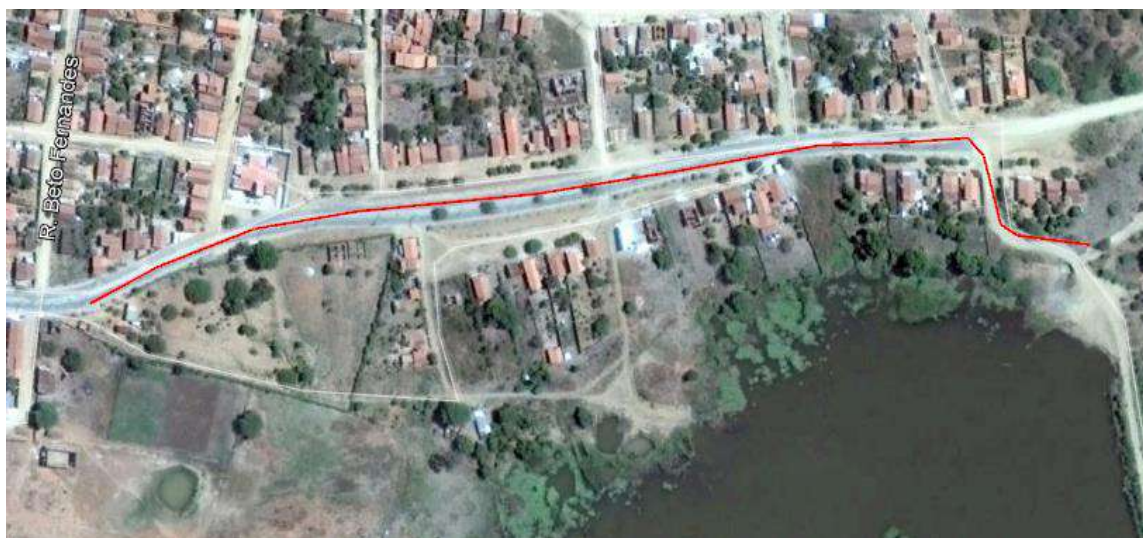
Figura 162 – Canal de Drenagem 03
