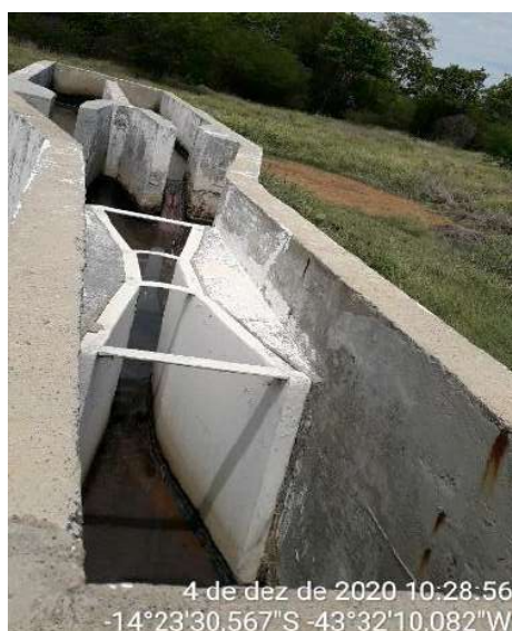
Figura 87 – Registros fotográficos da caixa de areia da ETE
