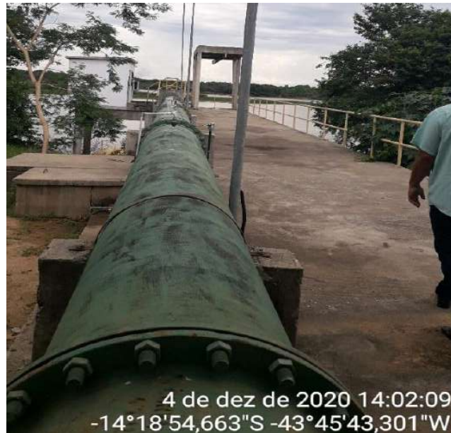
Figura 56 – Registro fotográfico da adutora de água bruta
