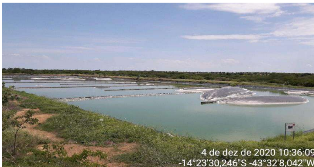
Figura 90 – Registro fotográfico lagoa de maturação
