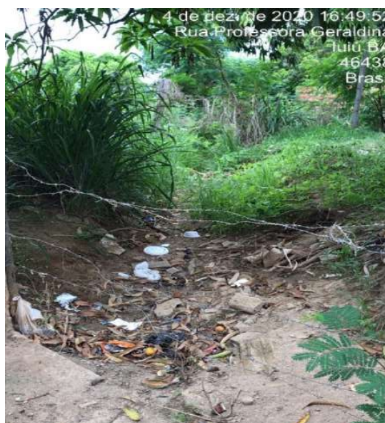
Figura 155 – Trecho do Canal de Drenagem 01 em terreno natural
