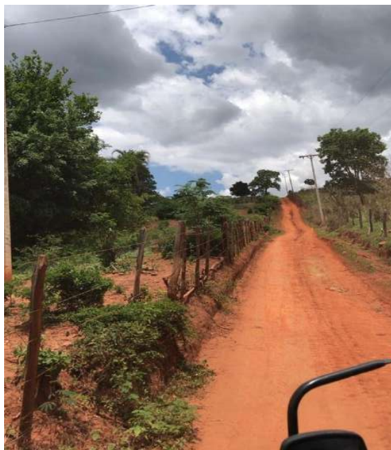
Figura 151 – Estrada vicinal sem pavimentação no município de Iuiú
