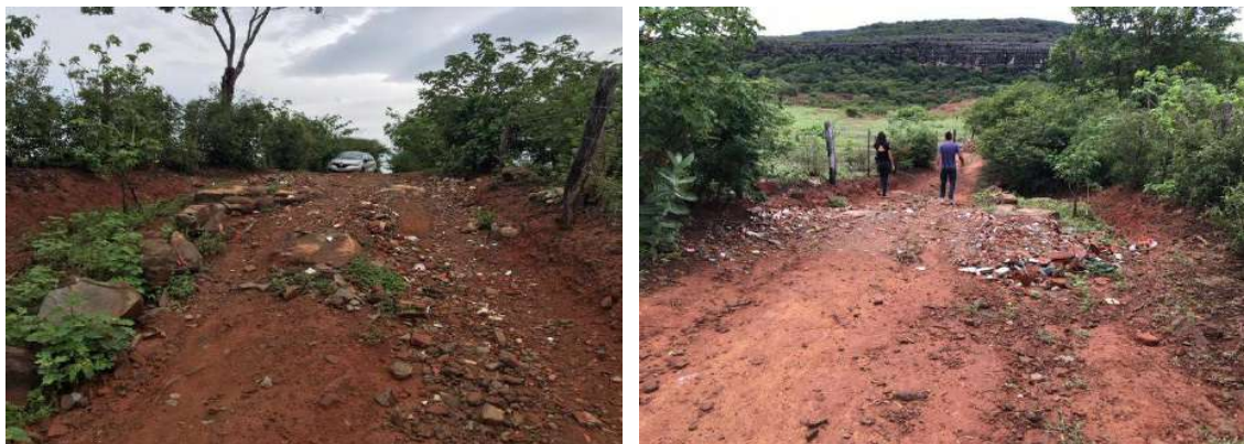
Figura 147 – Reaproveitamento de RCC em manutenção de estradas
