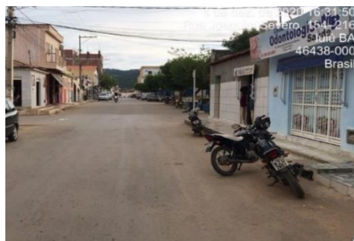
Figura 9 – Pavimentação do tipo asfáltica na rua Joaquim Severo Fonte: Seletiva, 2021.
