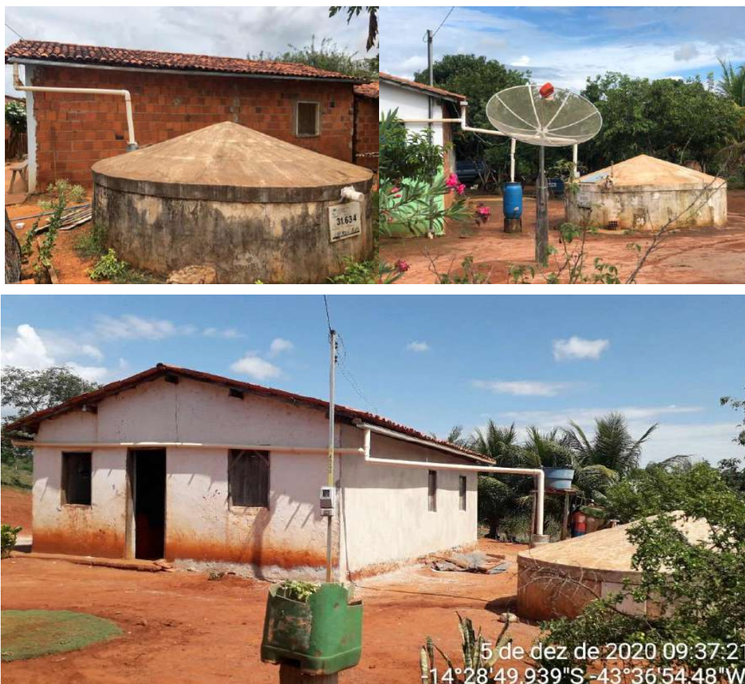
Figura 74 – Registro fotográfico das soluções de coleta e armazenamento de água da chuva em Iuiu
