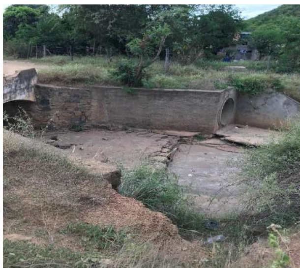
Figura 163 – Saída do Canal de Drenagem 03
