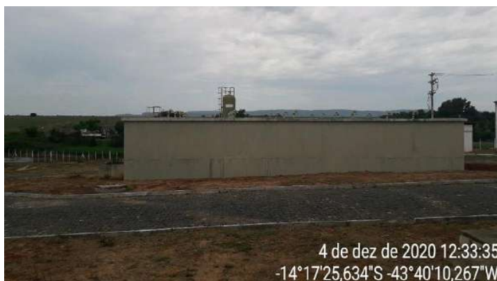
Figura 65 – Registros fotográfico do reservatório semienterrado de armazenamento da água tratada
