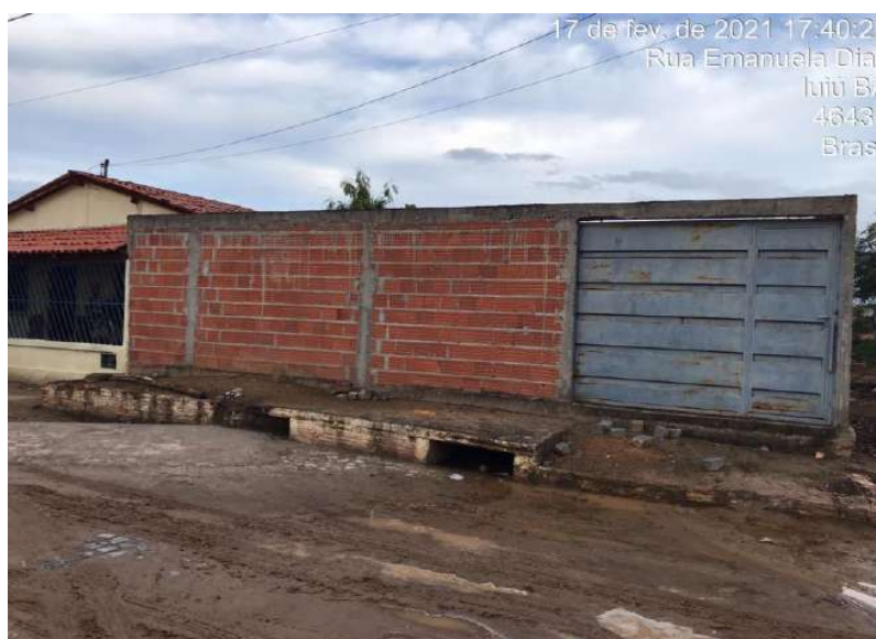
Figura 174 – Boca de lobo na rua Emanuela Dias
