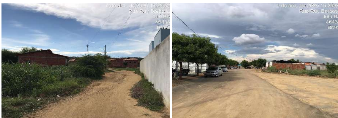
Figura 198 – Rua Rui Barbosa que possui problemas de drenagem
