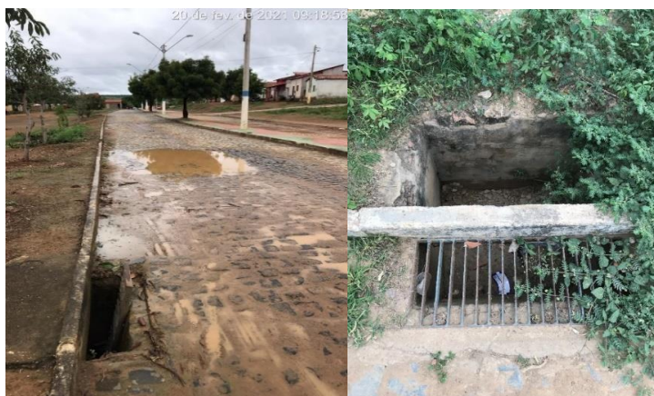
Figura 12 – Bocas de lobo existentes no bairro Barragem Fonte: Seletiva, 2021.
