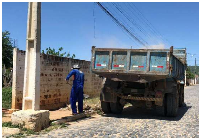
Figura 122 - Execução dos serviços de capina e caminhão de coleta
