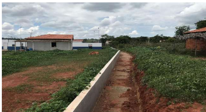
Figura 168 – Vala de infiltração na comunidade de Brejo Bezerra
