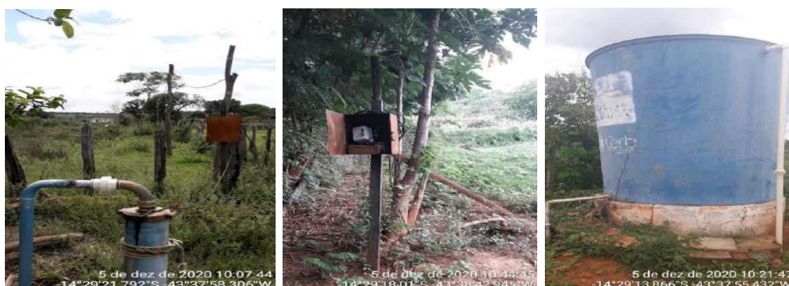
Figura 72 - Registros fotográficos do sistema de abastecimento de Brejo Bezerra
