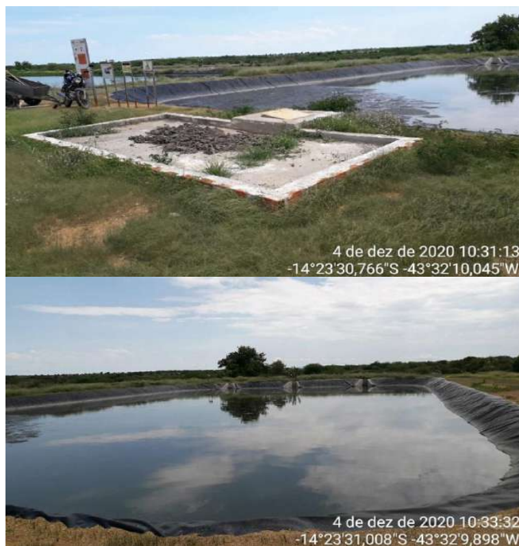
Figura 88 – Registros fotográficos da lagoa anaeróbia
