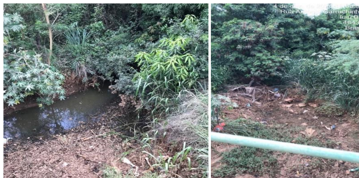
Figura 15 – Corpo hídrico assoreado e com resíduos
