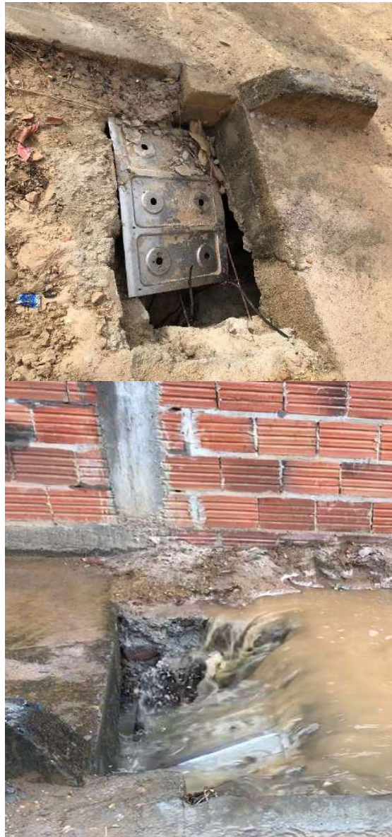
Figura 161 – Estrutura de drenagem direcionado para o Canal de Drenagem 02
