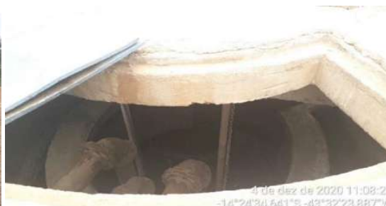
Figura 85 – Registros fotográficos da caixa de areia existente nas estações elevatórias de esgotos
