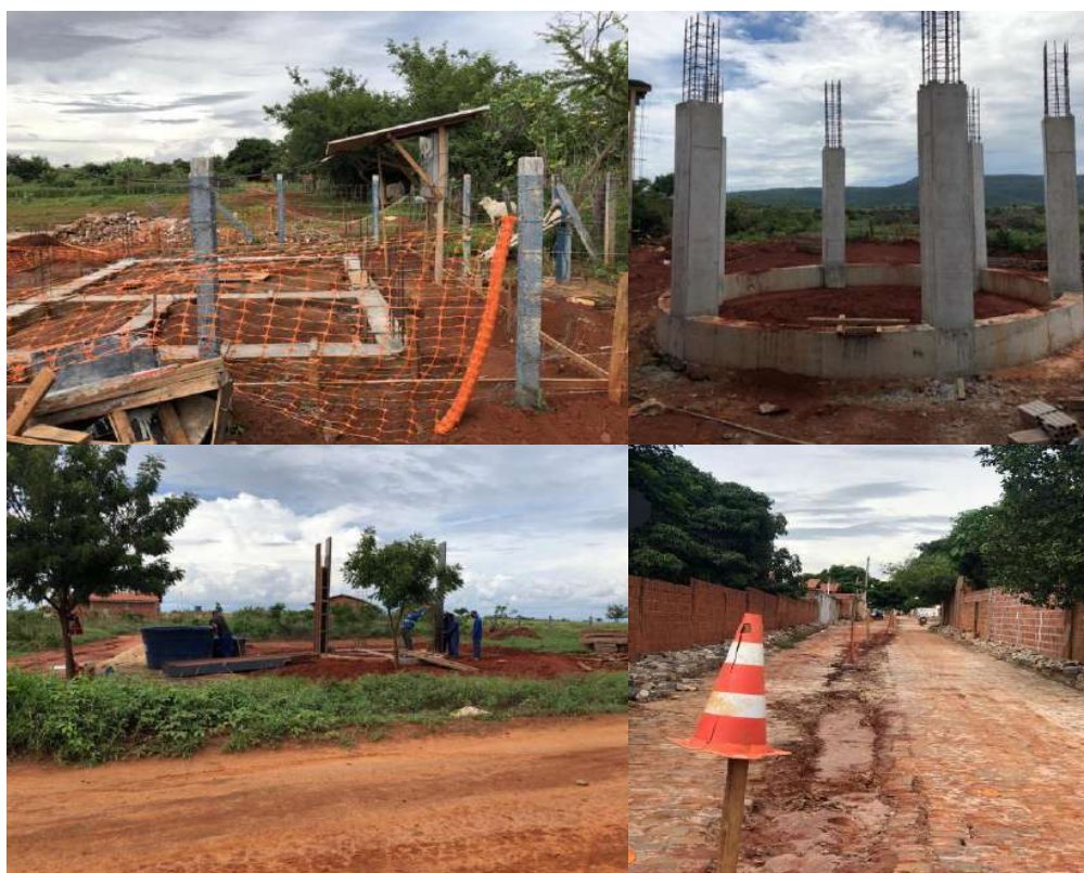
Figura 76 – Registros fotográficos da obra no distrito de Pindorama para construção do novo sistema de abastecimento de água
