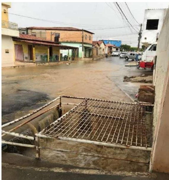
Figura 159 – Fluxo de água direcionado para o Canal de Drenagem 02
