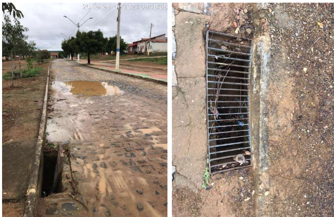
Figura 172 – Bocas de lobo existentes no bairro Barragem
