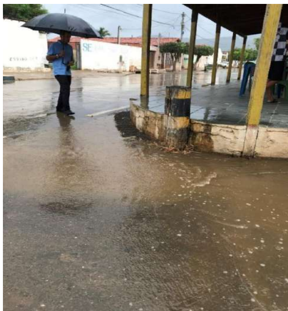
Figura 173 – Boca de lobo na rua Vicente Cristo Lopes
