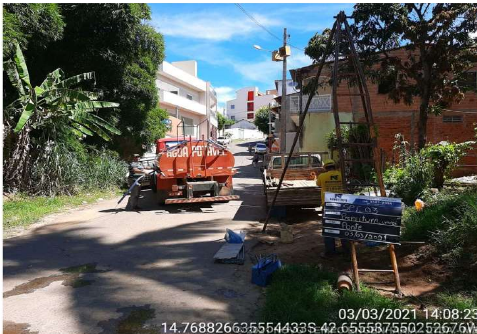
EXECUÇÃO SONDAGEM À PERCUSSÃO SP 03 - URANDI/BA
