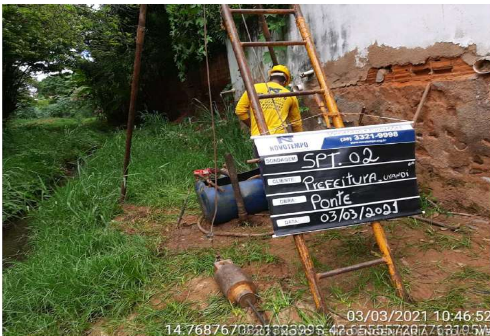
EXECUÇÃO SONDAGEM À PERCUSSÃO SP 02 - URANDI/BA
