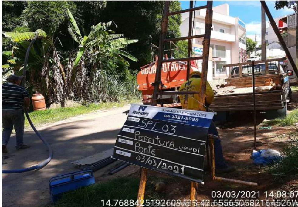
EXECUÇÃO SONDAGEM À PERCUSSÃO SP 03 - URANDI/BA
