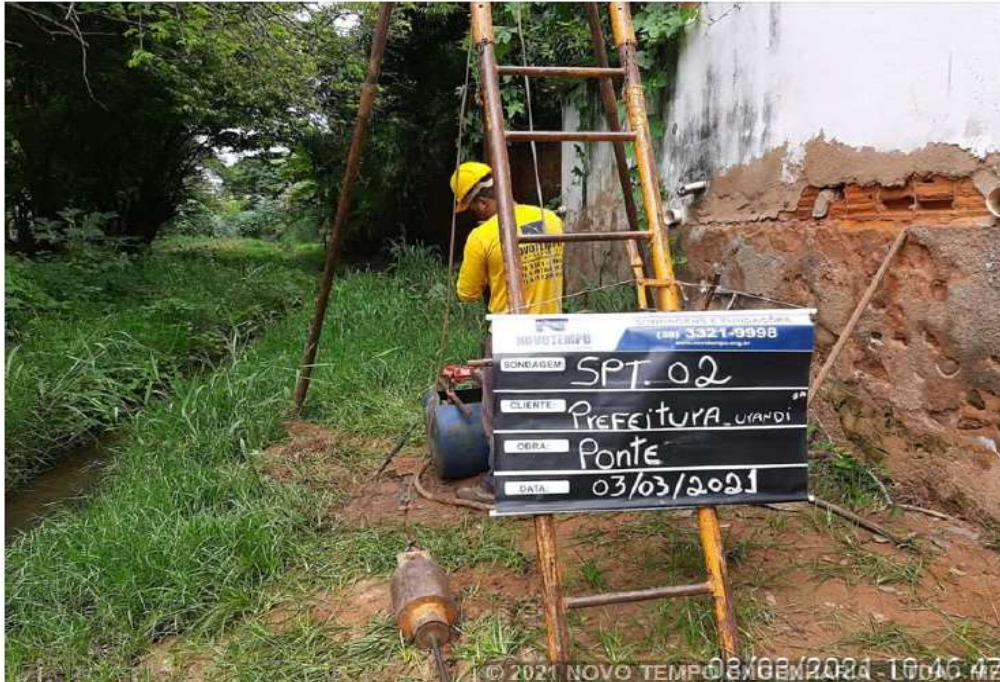
EXECUÇÃO SONDAGEM À PERCUSSÃO SP 02 - URANDI/BA
