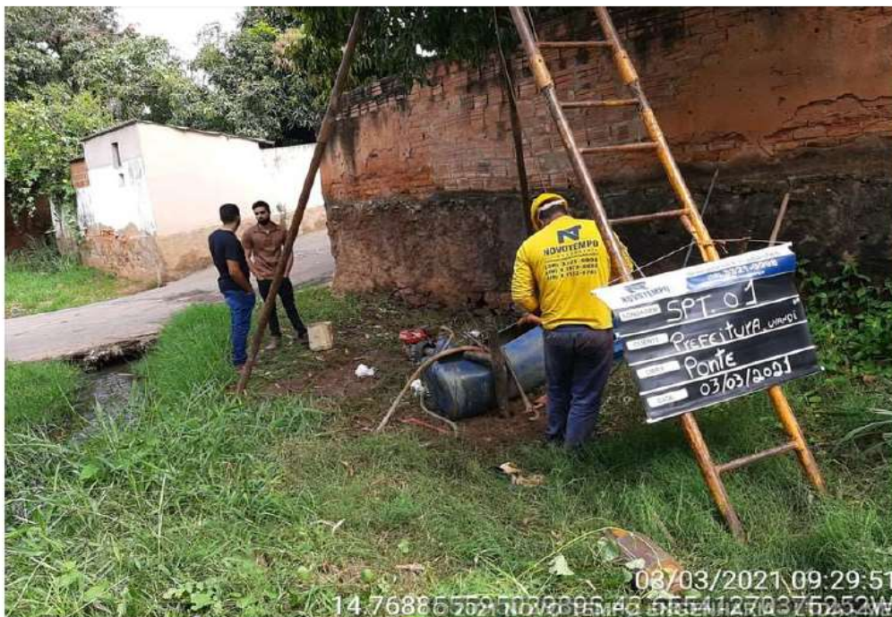
EXECUÇÃO SONDAAGEM À PERCUSSÃO SP 01 - URANDI/BA
