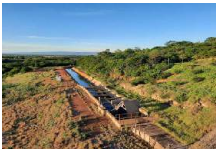
Figura 62 – Registro fotográfico do canal de irrigação da barragem Cova da Mandioca
