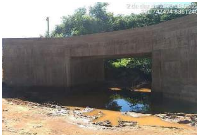
Figura 148 – Ponte sobre o rio Barra em construção (dezembro de 2020)
