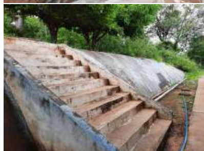
Parede de contenção do talude próximo à área dos reservatórios de água tratada
