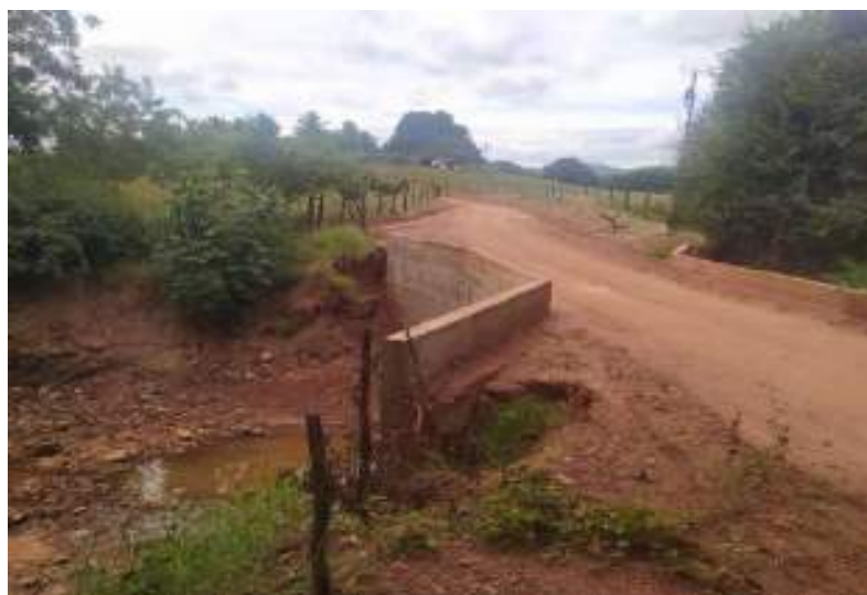
Figura 149 – Ponte sobre o rio Barra finalizada (abril de 2021)
