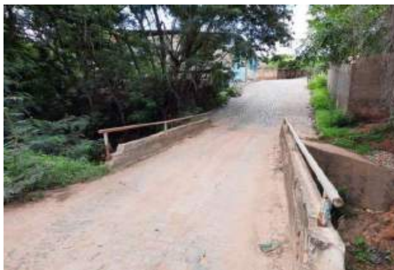
Figura 76 – Registro fotográfico da ponte sobre o Rio Cachoeira, na Travessa Deocleciano
