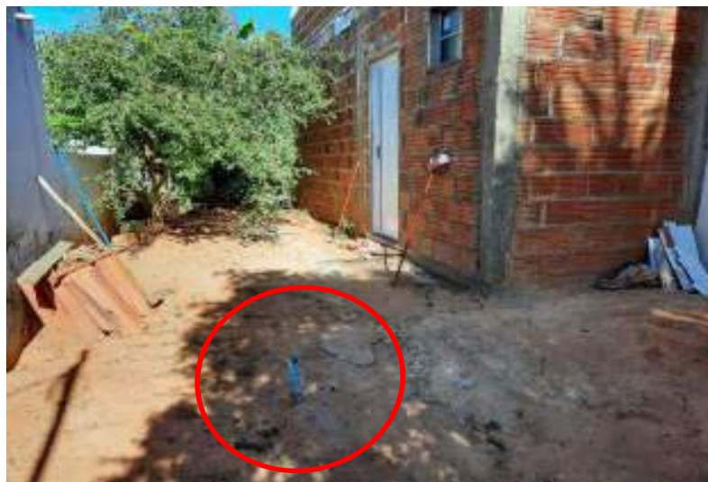
Figura 81 – Registro fotográfico de fossa rudimentar localizada na área rural do município de Urandi
