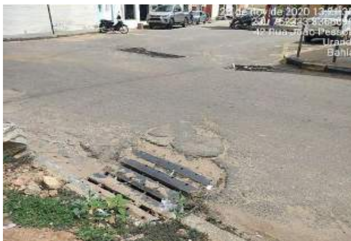
Figura 137 – Pavimentação do tipo asfáltica na rua João Pessoa
