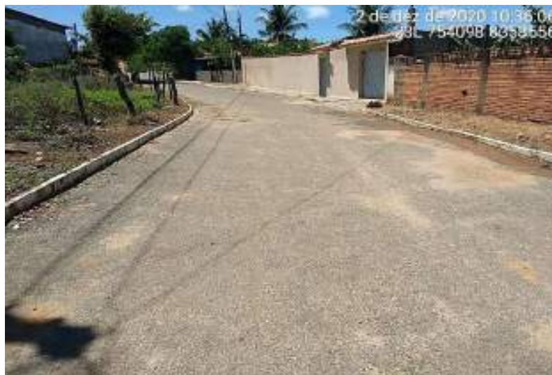
Figura 141 – Rua pavimentada na comunidade de Salinas
