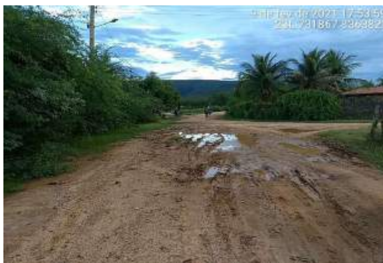
Figura 184 – Ponto crítico na comunidade de Núcleo II
