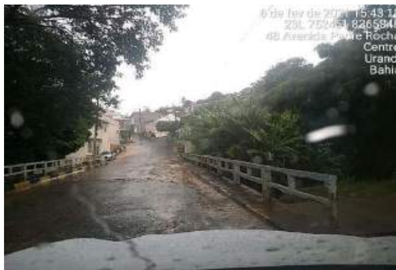
Figura 150 – Ponte sobre o rio Raiz
