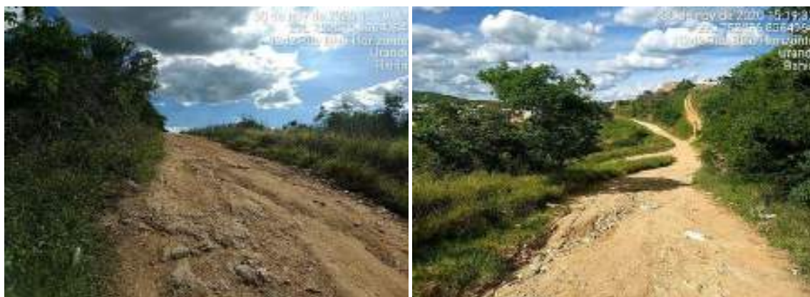
Figura 115 – Estrada de acesso ao lixão (esquerda) e vista do acesso para saída do lixão (direita)
