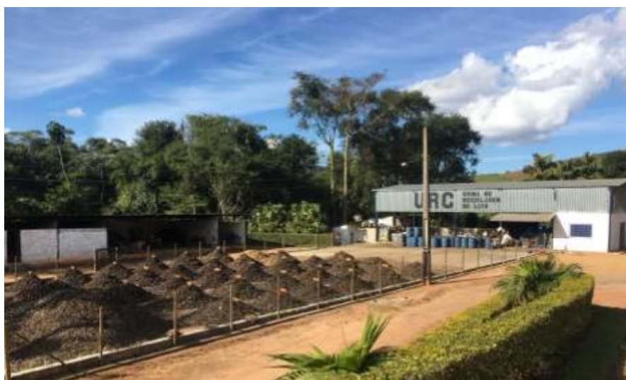
Figura 15 – Pátio de compostagem de resíduos orgânicos
