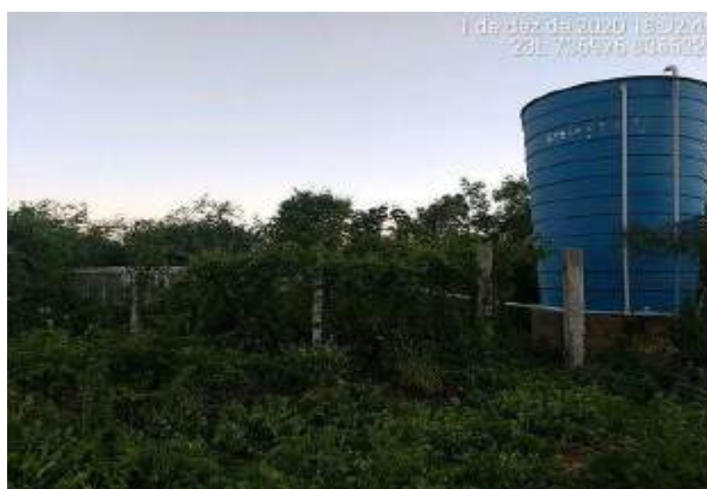
Figura 63 – Registro fotográfico do reservatório coletivo para abastecimento das comunidades de Cantinho e Lagoa Grande
