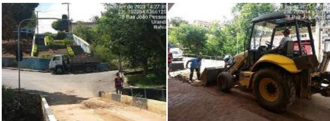
Figura 104 – Veículos utilizados para coleta de resíduos da construção civil (RCC) e volumosos realizando o respectivo recolhimento no bairro centro
