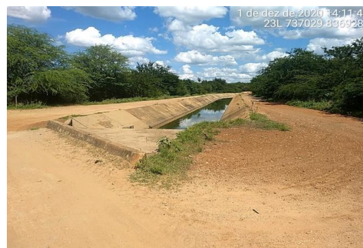
Figura 15 – Canal de irrigação Fonte: Seletiva, 2021.
