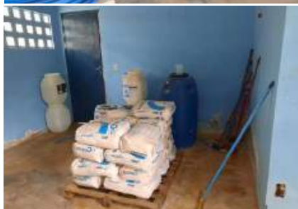
Casa de química
