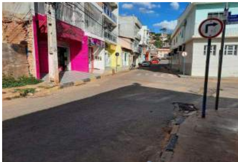
Figura 72 – Registro fotográfico da Avenida Abelardo Nina Rocha, onde está localizado trecho da rede coletora mista, para coleta de esgoto e das águas pluviais
