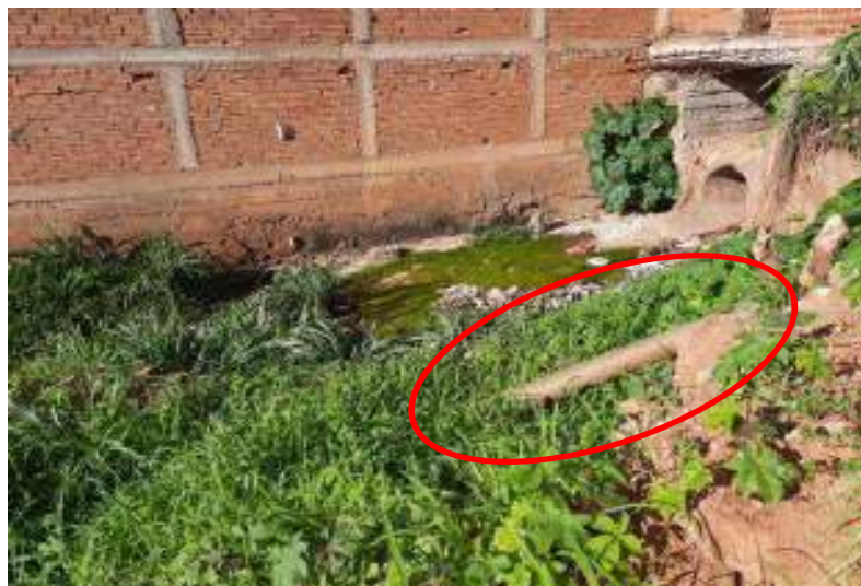
Figura 73 – Registro fotográfico da tubulação da rede coletora de esgotos, possível ser observada em terreno baldio à margem da Av. Padre Rocha
