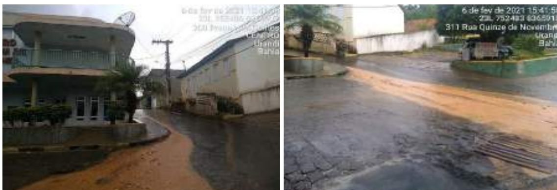
Figura 152 – Grelha próximo a prefeitura
