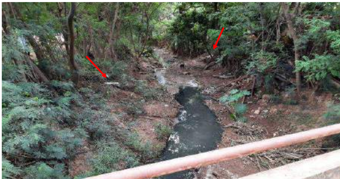
Figura 77 – Registro fotográfico do ponto de lançamento de esgoto in natura no Rio Cachoeira, próximo à ponte localizada na Travessa Deocleciano
