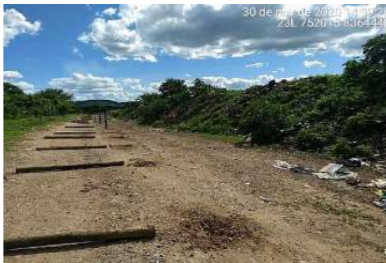
Figura 118 – Mourões de madeira dispostos para instalação do cercamento
