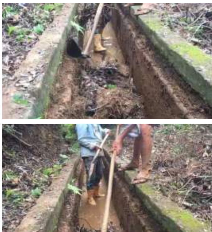
Figura 43 – Registro fotográfico da limpeza do canal à céu aberto
