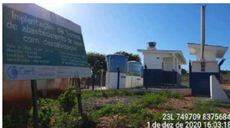
Figura 58 – Registro fotográfico da solução coletiva implementada por meio do Programa Água Doce na comunidade de Barreiro I
