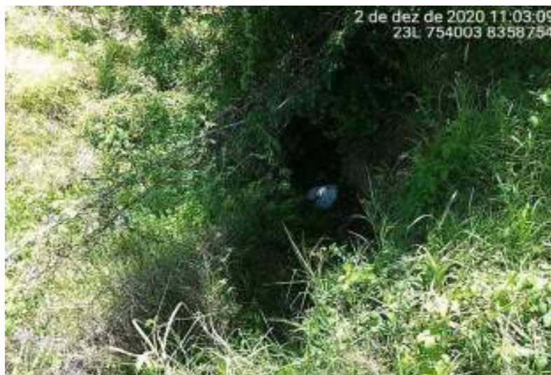
Figura 80 – Registro fotográfico de ponto de lançamento de esgotos in natura , no povoado rural de Salinas
