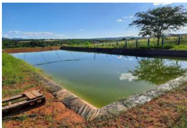
Figura 60 – Registro fotográfico do tanque de criação de peixes onde é feita a destinação da água de limpeza das membranas de dessalinização da solução coletiva de abastecimento da comunidade de Barreiro I
