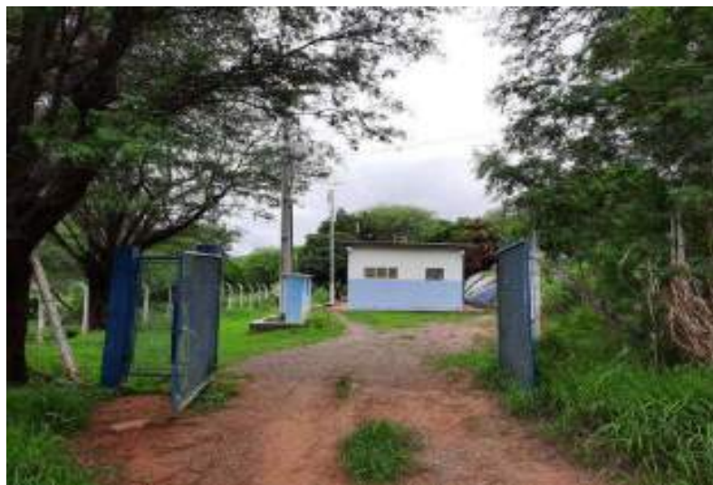
Figura 44 – Registro fotográfico da entrada da ETA compacta
