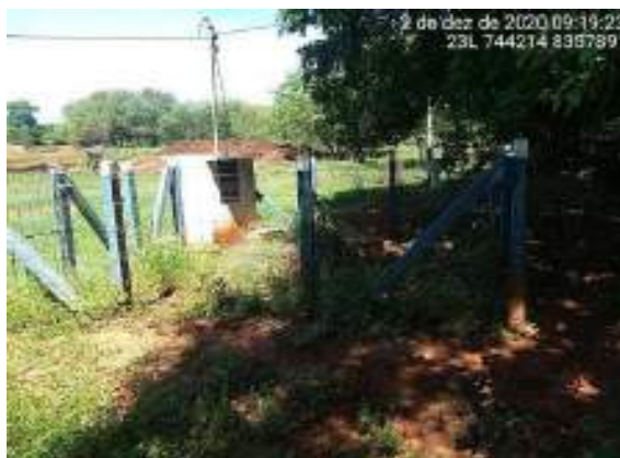
Vista da área do poço artesiano
