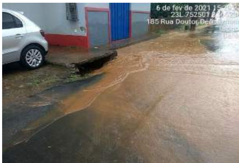
Figura 161 – Boca de lobo na rua Dr. Deocleciano
