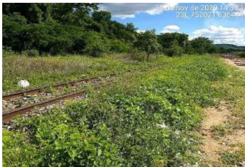
Figura 119 – Linha férrea na divisa com o lixão (mourões de madeira no canto direito da foto)
