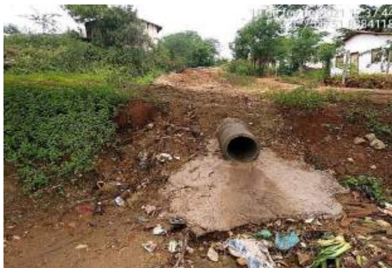
Figura 154 – Bueiro em Poções para transposição de via
