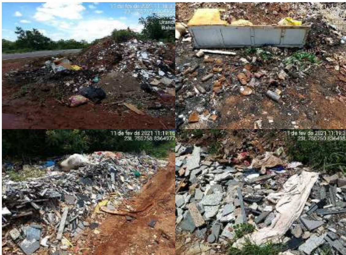
Figura 133 – Bota fora para de resíduos da construção civil (RCC)
