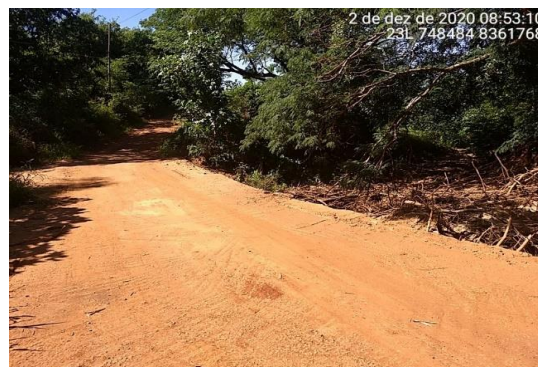
Figura 11 – Estrada sem pavimento na comunidade de Capa Fonte: Seletiva, 2021.
