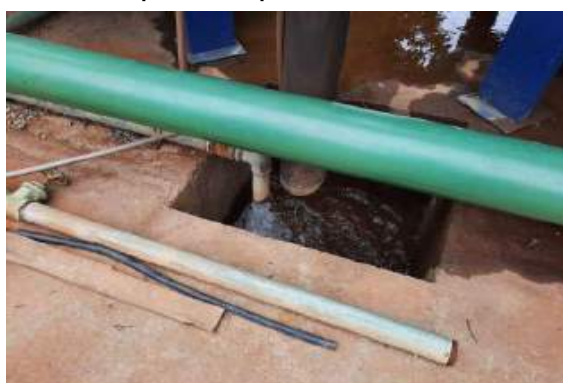
Mecanismo de descarga dos filtros da ETA compacta
