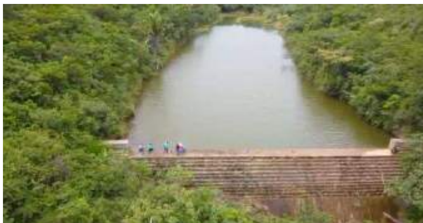
Figura 42 – Registro fotográfico do barramento do Rio Raiz
