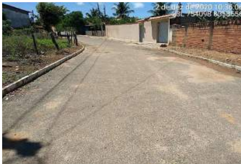
Figura 141 – Rua pavimentada na comunidade de Salinas
