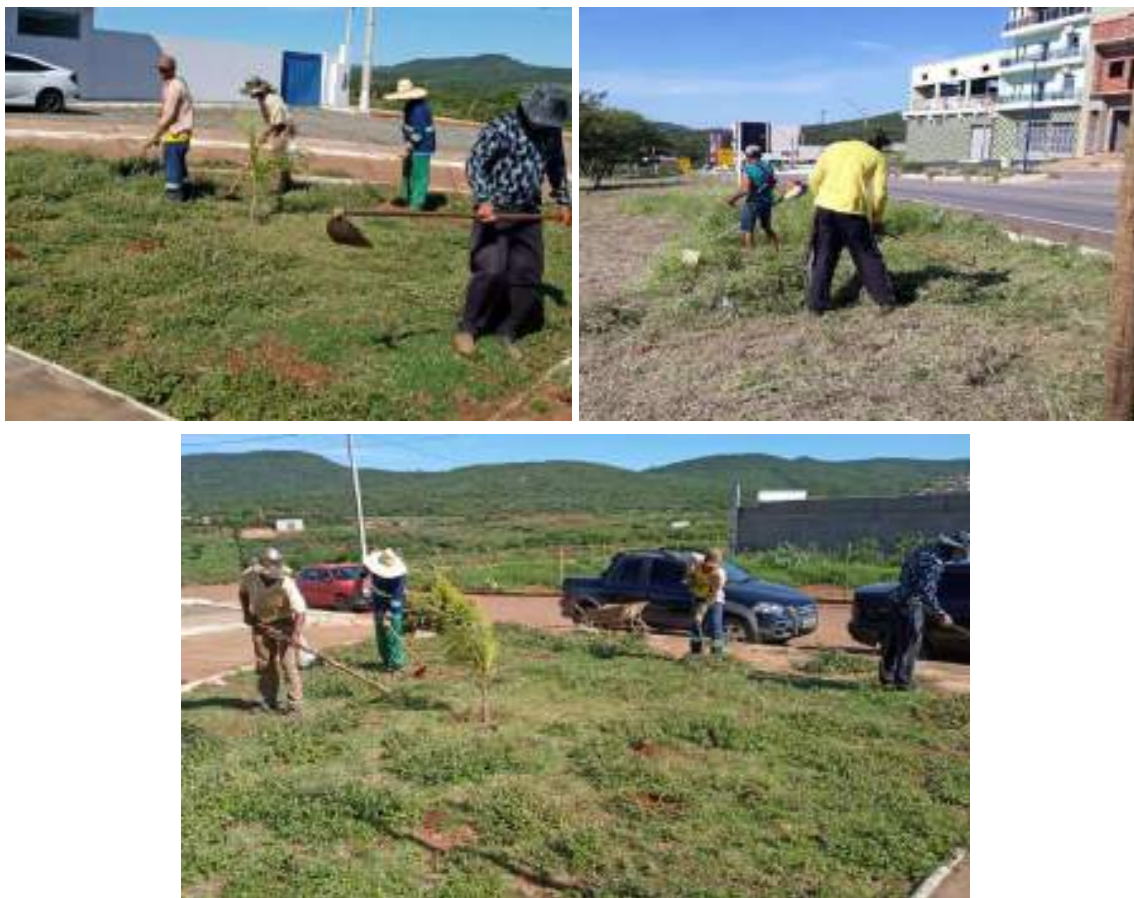
Figura 111 – Execução dos serviços de roçagem e capina
