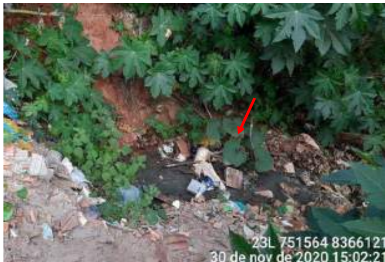
Figura 75 – Registro fotográfico do lançamento de esgoto in natura no solo, à margem da rodovia BR-122, no bairro Xavier
