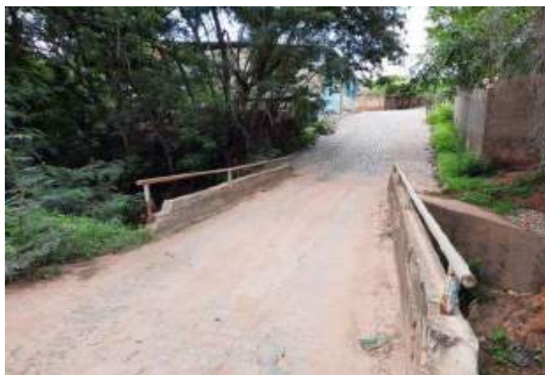
Figura 76 – Registro fotográfico da ponte sobre o Rio Cachoeira, na Travessa Deocleciano
