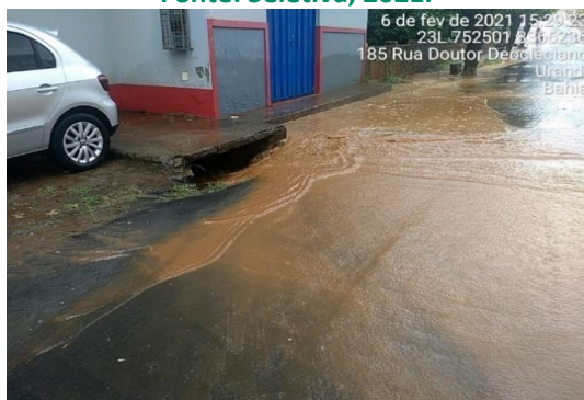
Figura 14 – Bocas de lobo na rua Dr. Deocleciano Fonte: Seletiva, 2021.
