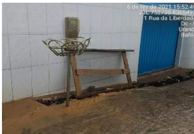
Figura 153 – Grelha próximo ao hospital municipal
