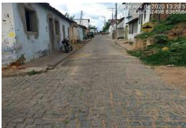
Figura 138 – Pavimentação do tipo poliédrica na rua Santos Dumont
