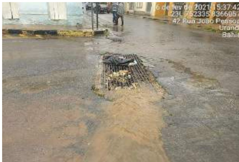
Figura 160 – Boca de lobo na via que contorna a Praça Ananias de Matos
