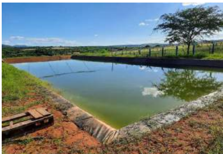
Figura 60 – Registro fotográfico do tanque de criação de peixes onde é feita a destinação da água de limpeza das membranas de dessalinização da solução coletiva de abastecimento da comunidade de Barreiro I
