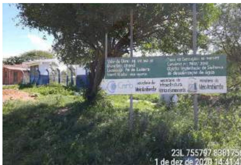
Figura 54 – Registro fotográfico da solução coletiva implementada por meio do Programa Água Doce na comunidade de Pé da Ladeira
