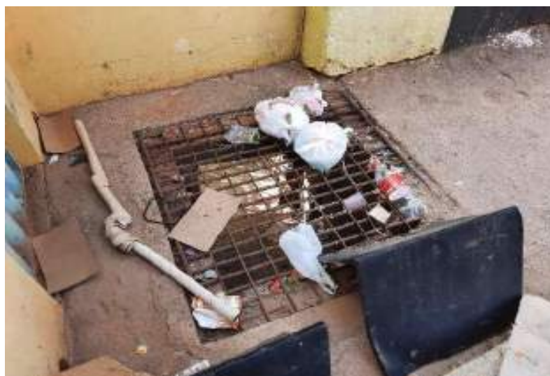
Figura 162 – Grelha próxima a ponte sob o rio Cachoeira
