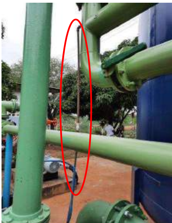
Figura 49 – Registro fotográfico do ponto de adição dos compostos químicos na água após a saída dos filtros
