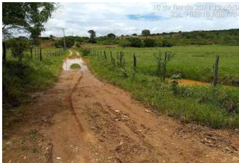
Figura 182 – Ponto crítico na estrada que interliga a comunidade de Poções às comunidades de Barreirinho e Canudos
