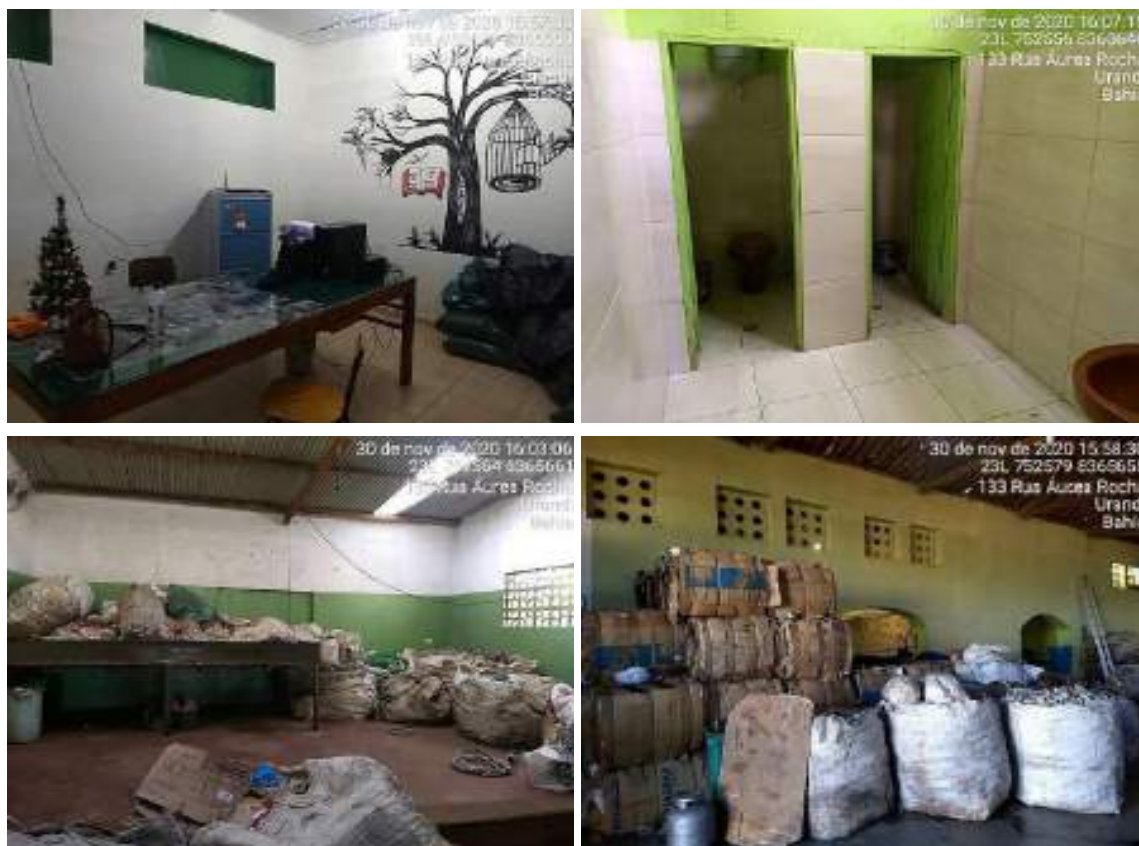
Figura 123 – Infraestrutura básica do galpão: escritório, banheiros, área de recepção; armazenamento dos materiais recicláveis triados e prensados
