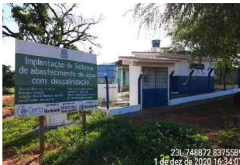
Figura 56 – Registro fotográfico da solução coletiva implementada por meio do Programa Água Doce na comunidade de Covas da Mandioca
