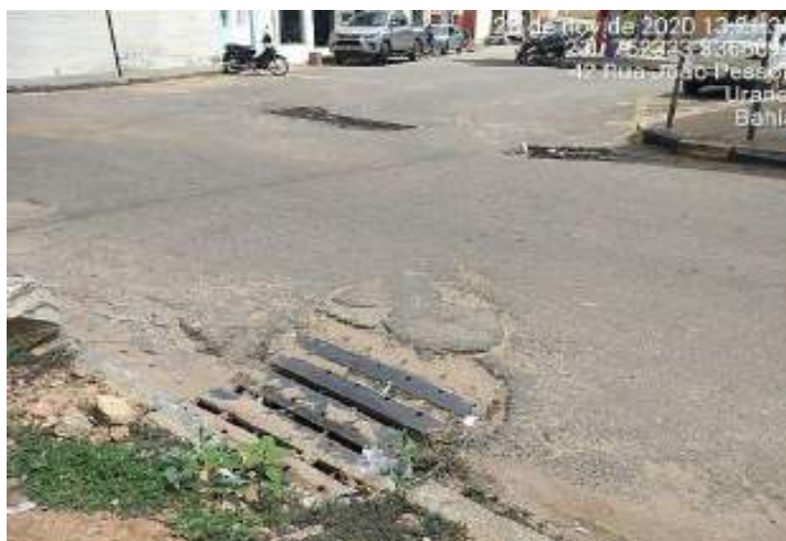
Figura 137 – Pavimentação do tipo asfáltica na rua João Pessoa
