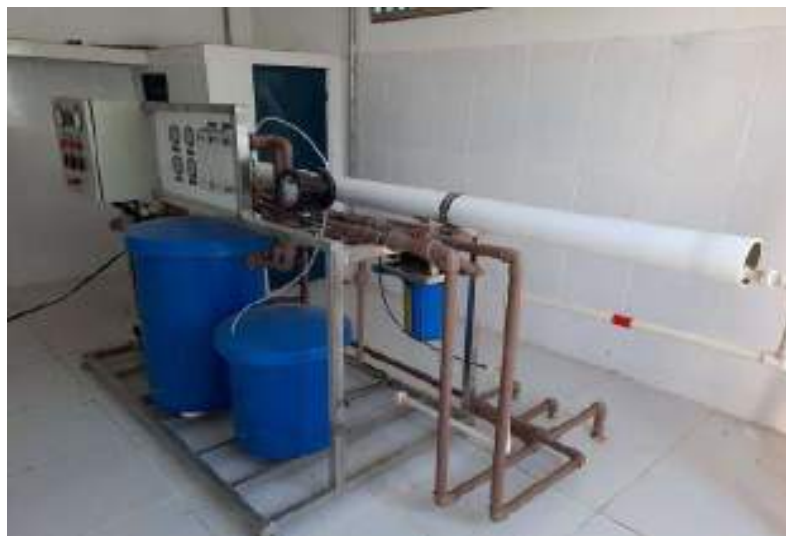
Figura 55 – Registro fotográfico do dessalinizador da solução coletiva implementada por meio do Programa Água Doce na comunidade de Pé da Ladeira
