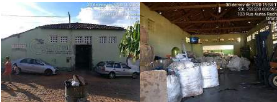
Figura 122 – Galpão utilizado pela COTRAU para as atividades de comercialização dos recicláveis
