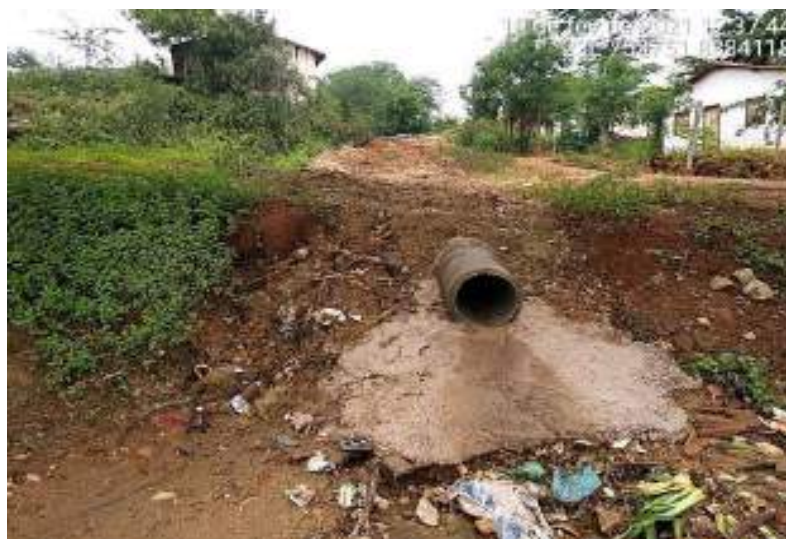
Figura 154 – Bueiro em Poções para transposição de via
