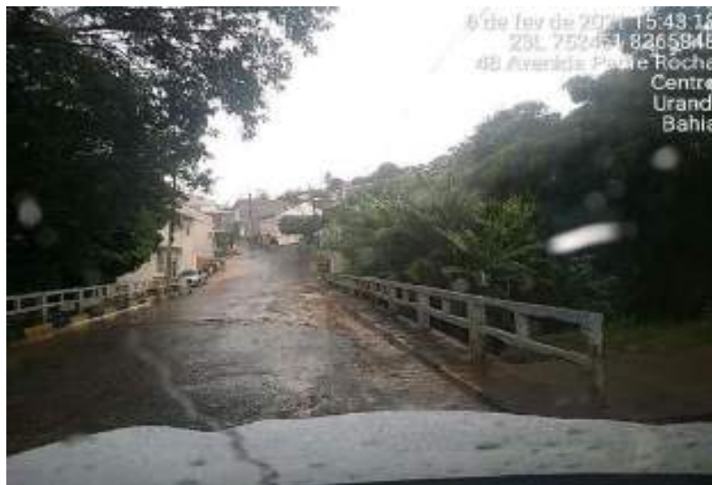
Figura 150 – Ponte sobre o rio Raiz
