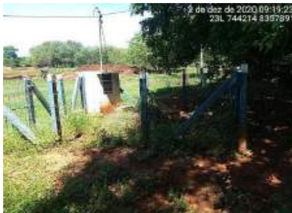
Vista da área do poço artesiano
