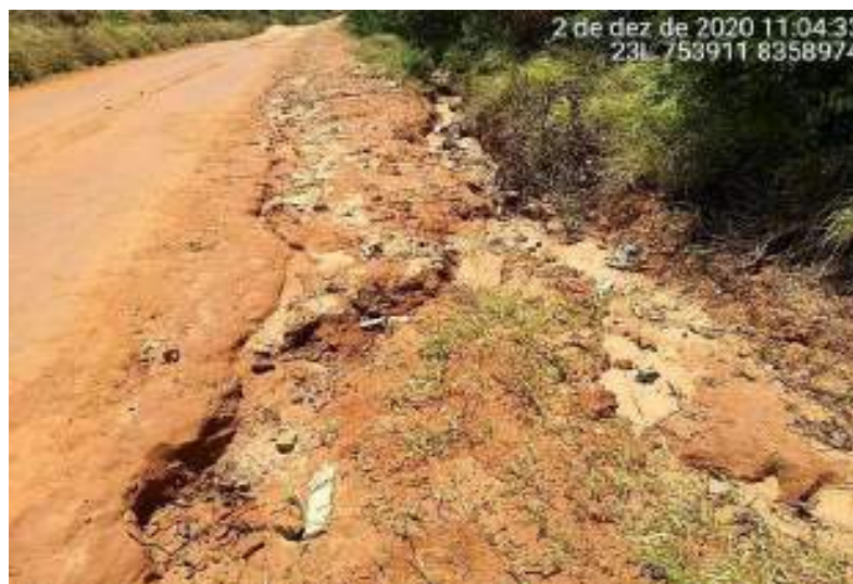
Figura 163 – Vala de infiltração implantada em estrada vicinal no município de Urandi
