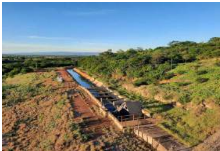
Figura 62 – Registro fotográfico do canal de irrigação da barragem Cova da Mandioca
