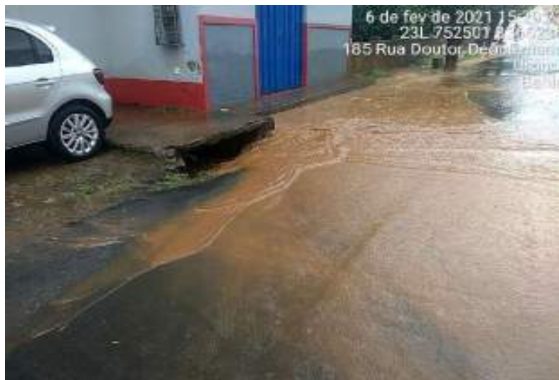
Figura 161 – Boca de lobo na rua Dr. Deocleciano
