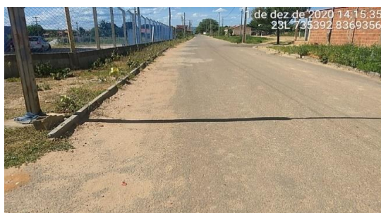
Figura 9 – Pavimento do tipo asfáltico na comunidade de Cantinho Fonte: Seletiva, 2021.
