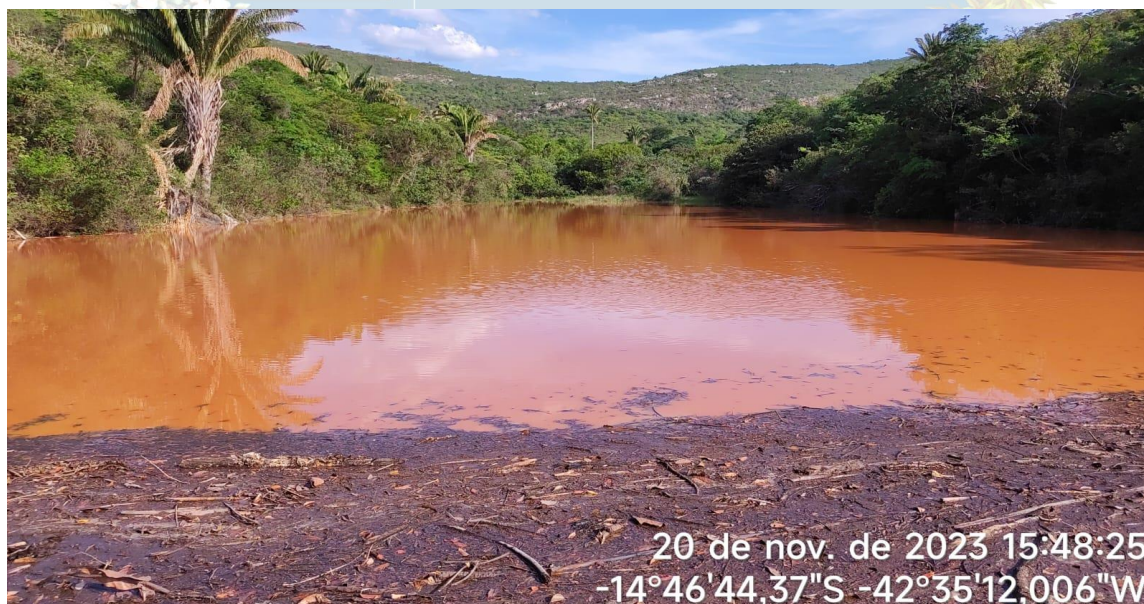
Figura 07: Vista da Barragem após o ocorrido
