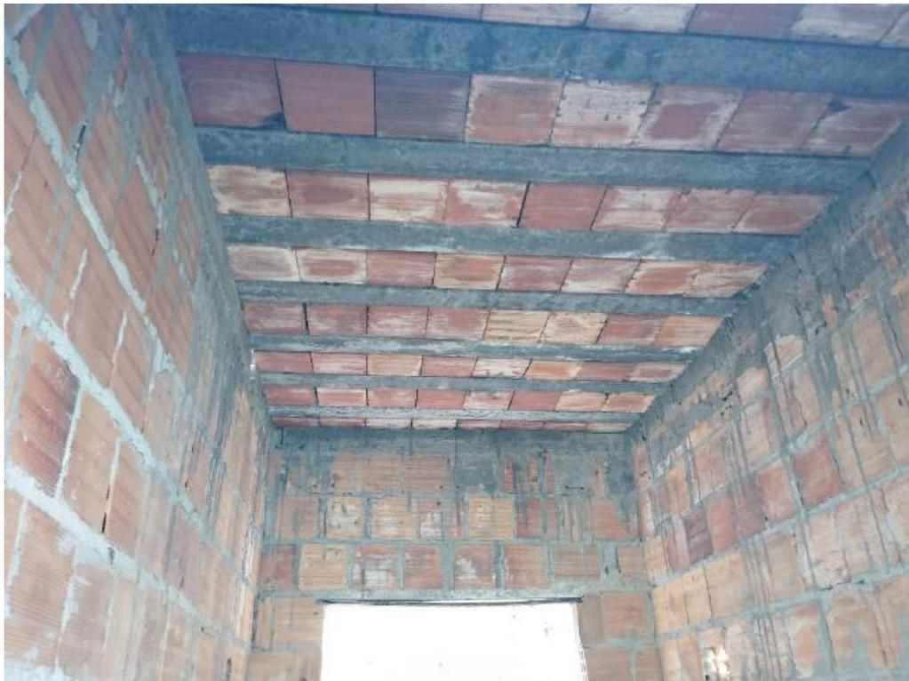
Figura 11 – Vista interna do lote – laje pré-moldada executada
