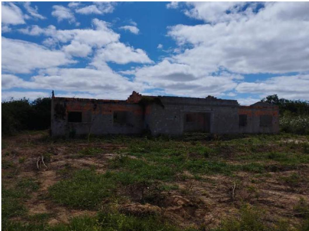
Figura 8 – Vista externa do lote – Obra sem serviços preliminares com vegetação rasteira na fachada posterior. Fonte: elaboração própria. (20/05/2024).
