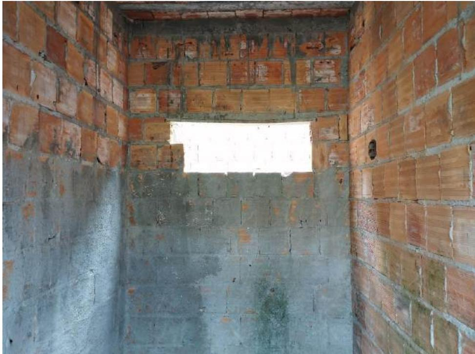
Figura 12 – Vista atual do lote – Vergas executada, porém em desconformidade com a NBR
