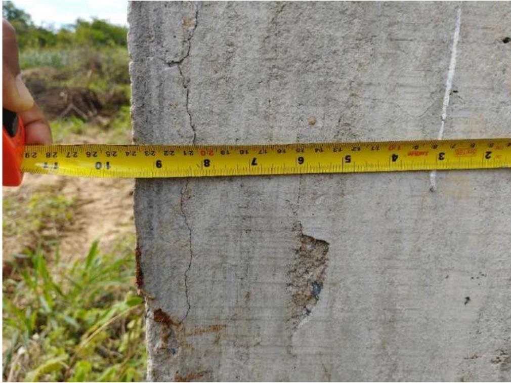
Figura 25 – Fissuras aparentes no concreto do pilar
