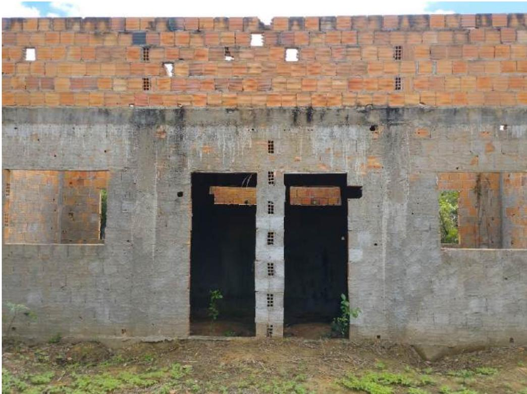
Figura 20 – Sanitários executados – vedações, superestrutura e laje pré-moldada
