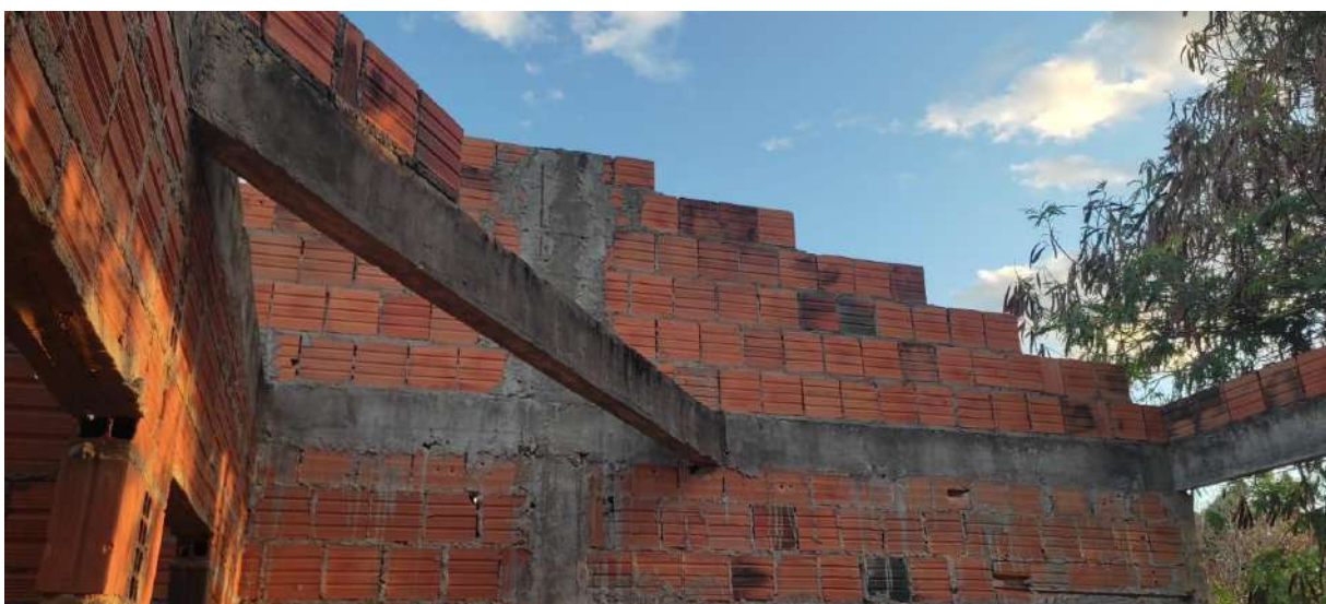
Figura 20 –1- Execução de viga não prevista. Fonte: elaboração própria
