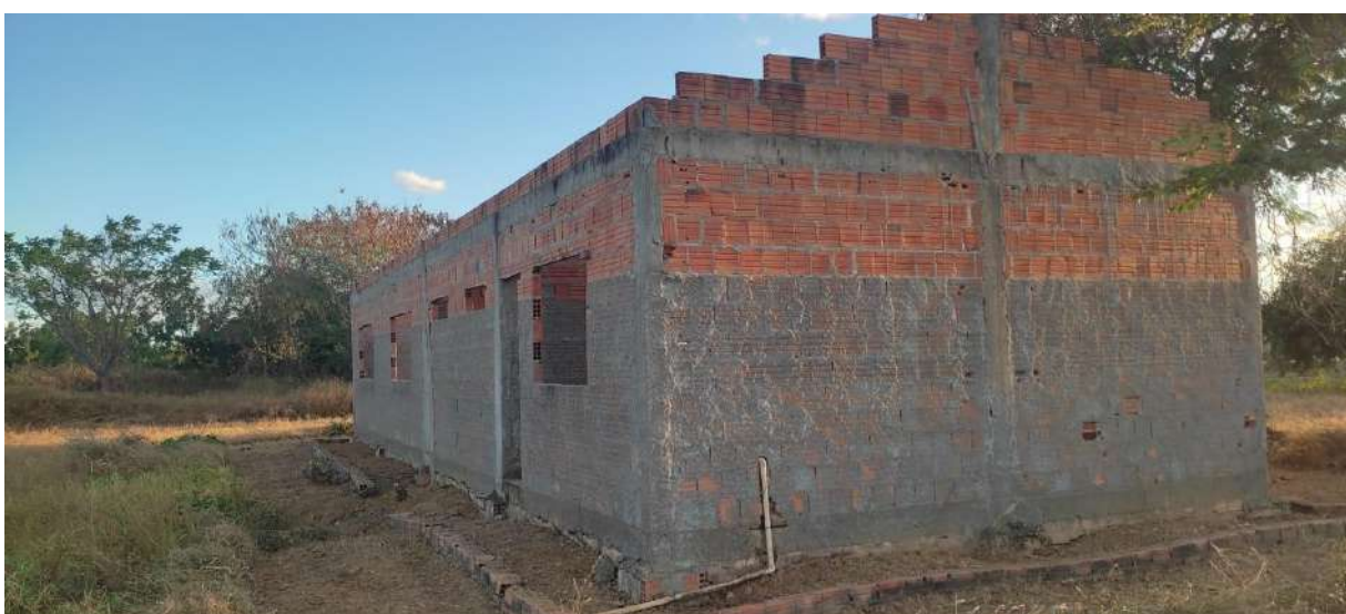
Figura 14 –1- Perfuração de viga baldrame para passagem de tubulação. 2- Baldrame não impermeabilizada. 3- Execução de alvenaria. Fonte: elaboração própria
