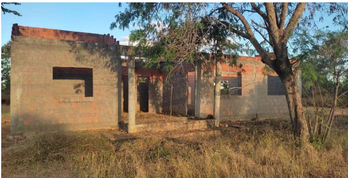
Figura 3 - Vista do acesso ao terreno. Fonte: elaboração própria
