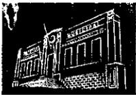
aproximadamente 380,00 m<sup>2</sup> de área construída em um terreno de 482,30 m<sup>2</sup>, edificadas em alvenaria de bloco cerâmico e estrutura de concreto armado, distribuídas em dois pavimentos cada, com cobertura em estrutura de madeira e telhas cerâmicas.
