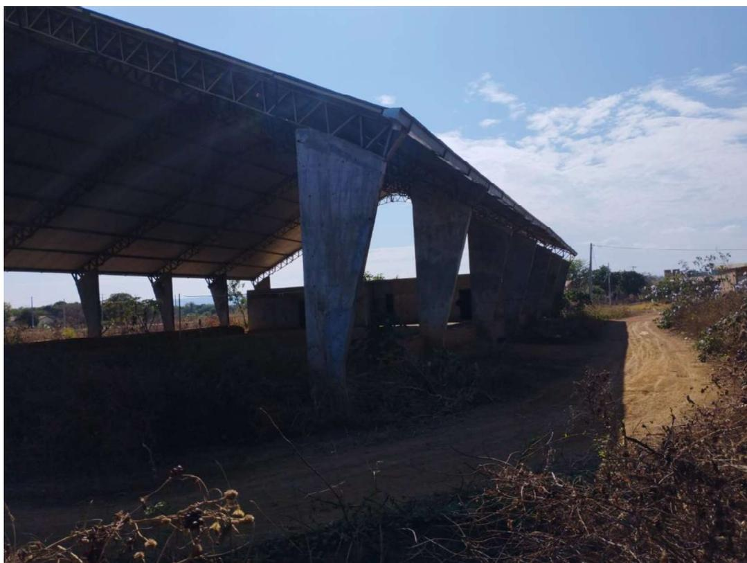
Figura 21 – Apoio da estrutura metálica em pilar trapezoidal com calha de cobertura.
