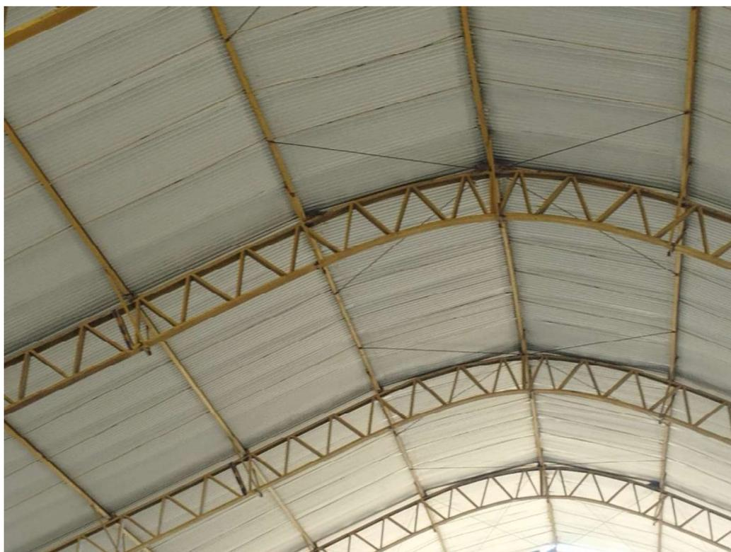
Figura 17 – Estrutura de cobertura e telhamento metálico da quadra.
