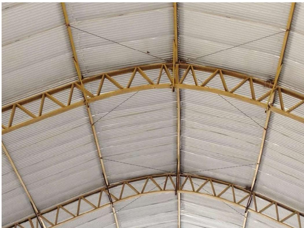
Figura 19 – Estrutura e telhamento metálico da quadra.
