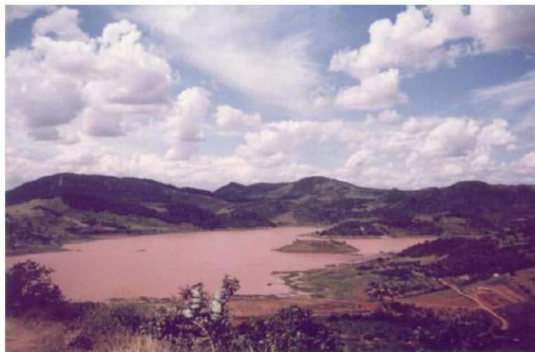
Figura 5 – Vista Panorâmica da barragem de Ceraíma.
