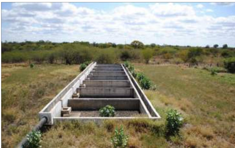
Figura 6.86 – Leitos de secagem da ETE de Carinhanha.
