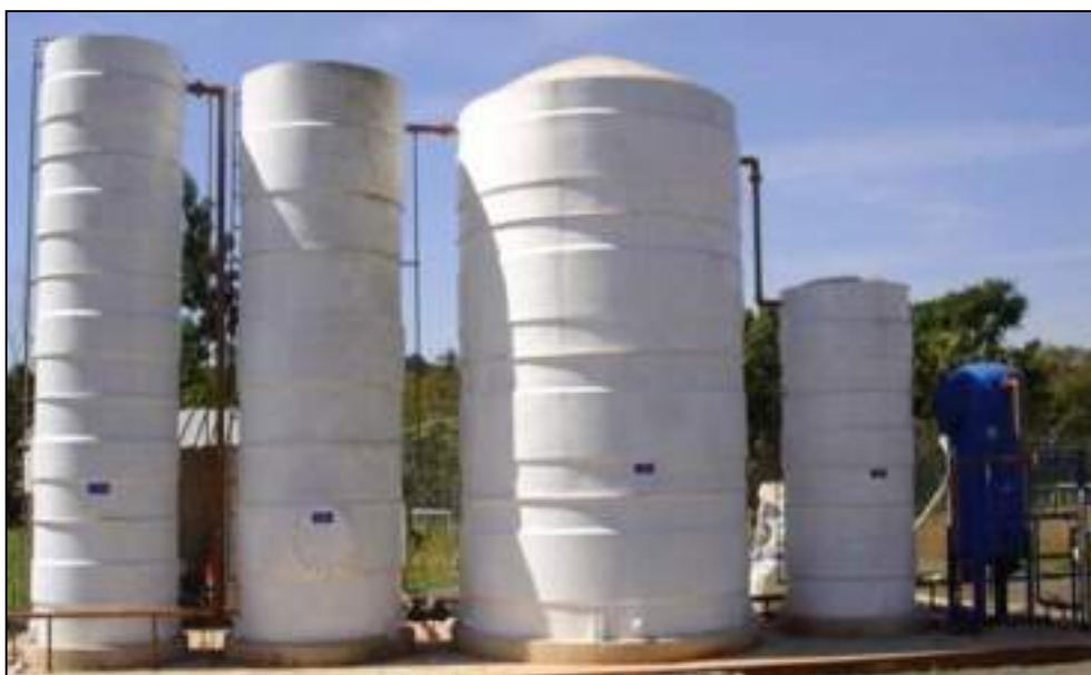
Figura 6.96 – Estação compacta de tratamento de esgoto sanitário. Fonte: DRZ Geotecnologia e Consultoria.
