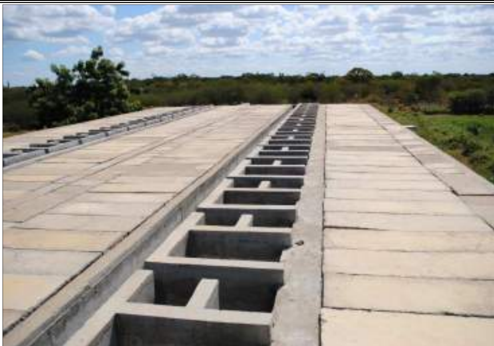
Figura 6.85 – Parte superior dos DAFA da ETE de Carinhanha.
