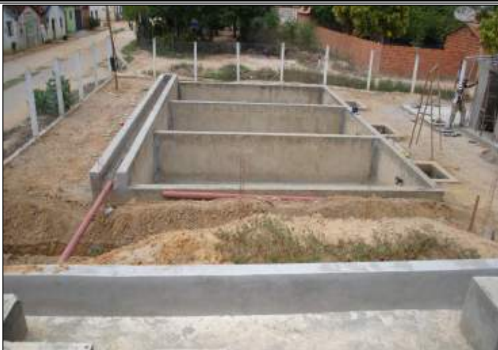
Figura 6.49 – Leito de secagem do filtro da ETA de Barra do Parateca. Fonte: DRZ Geotecnologia e Consultoria (2015).
