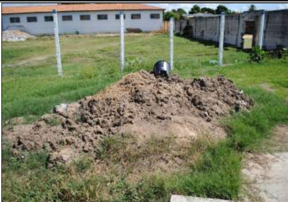
Figura 6.82 – Disposição irregular de lodo na EEE 01.
