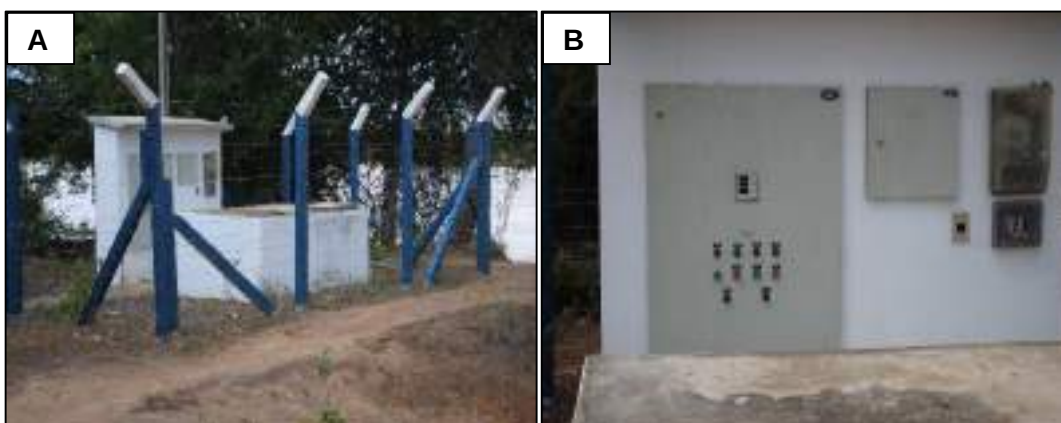
Figura 6.57 – Padrão de energia e quadro de comando do sistema de captação. Fonte: DRZ Geotecnologia e Consultoria (2015).
