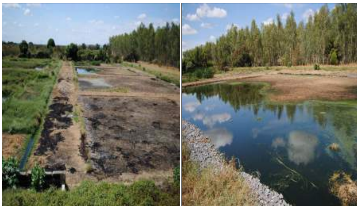
Figura 6.87 – Leitos de macrófitas ETE de Carinhanha.
