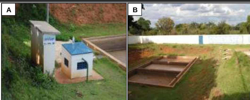
Figura 6.69 – Casa de força e casa de bombas e leito de secagem. Fonte: DRZ Geotecnologia e Consultoria (2015).
