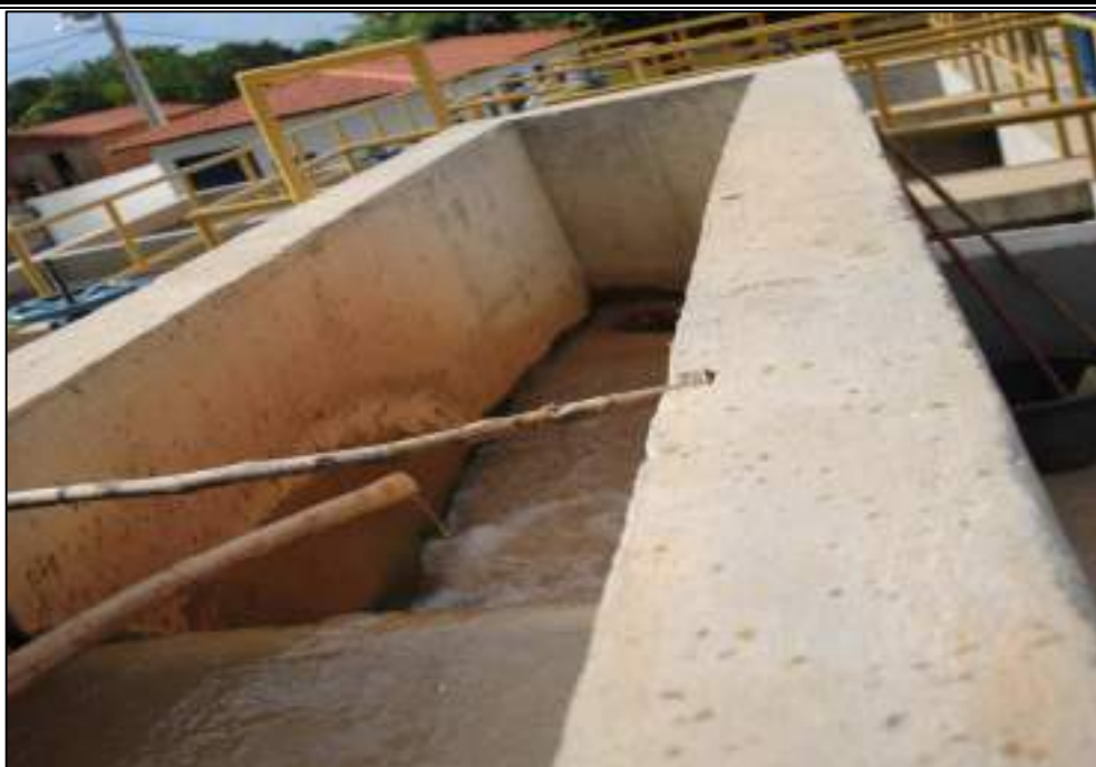
Figura 6.58 – Entrada de água bruta e dosador de sulfato. Fonte: DRZ Geotecnologia e Consultoria (2015).
