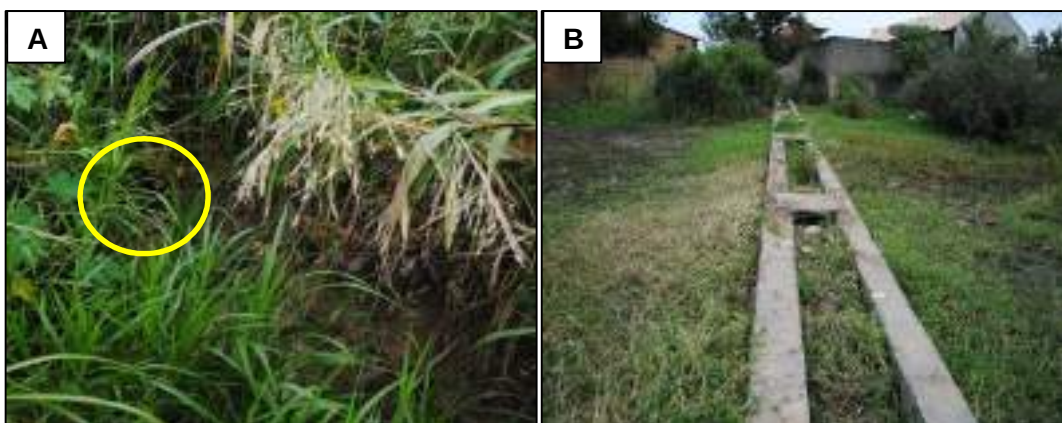
Figura 6.154 – Falta de manutenção e limpeza do sistema de drenagem. Fonte: DRZ Geotecnologia e Consultoria (2015).
