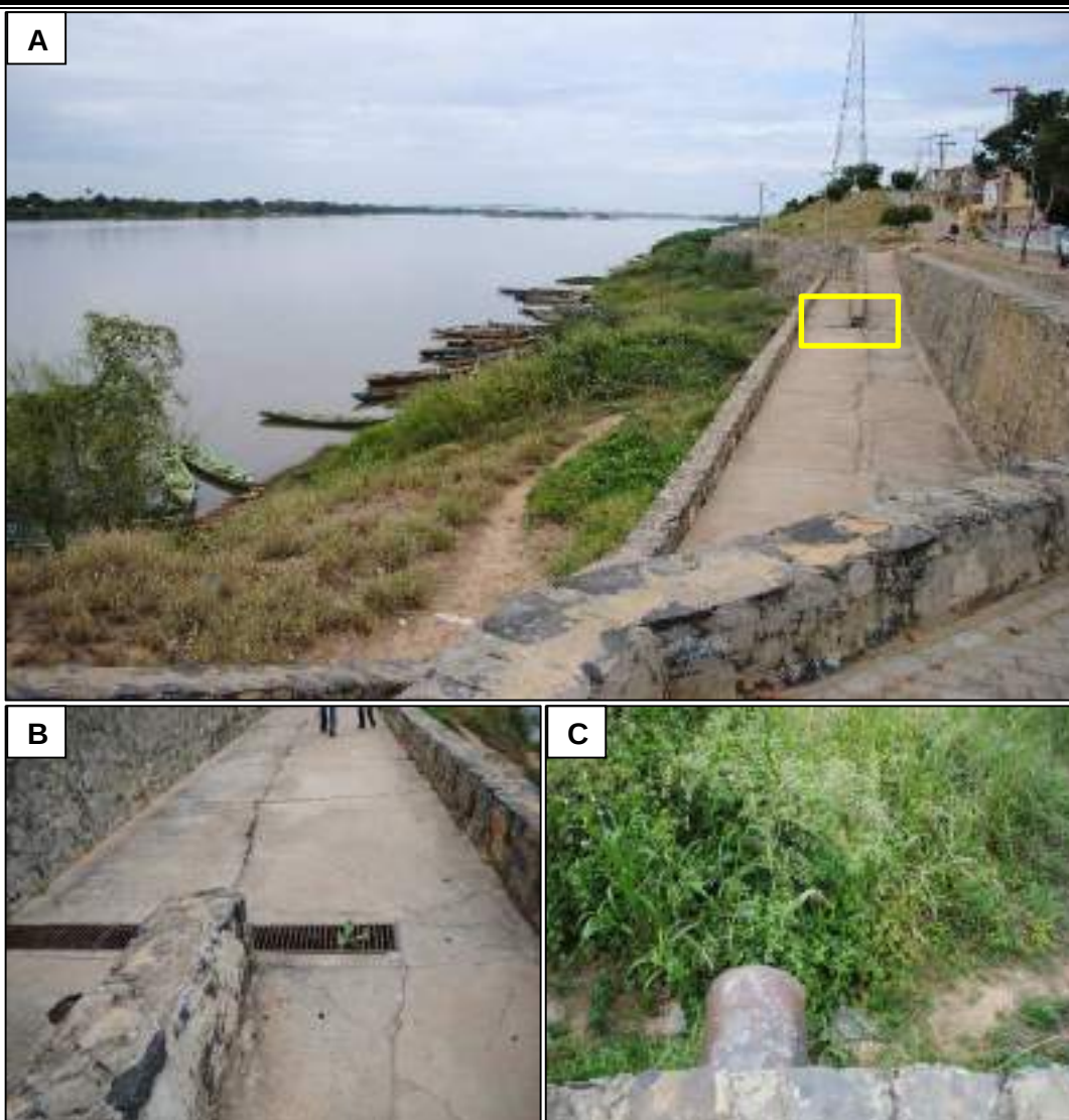
Figura 6.136 – Dispositivos de drenagem na orla de Carinhanha. Fonte: DRZ Geotecnologia e Consultoria (2015).
