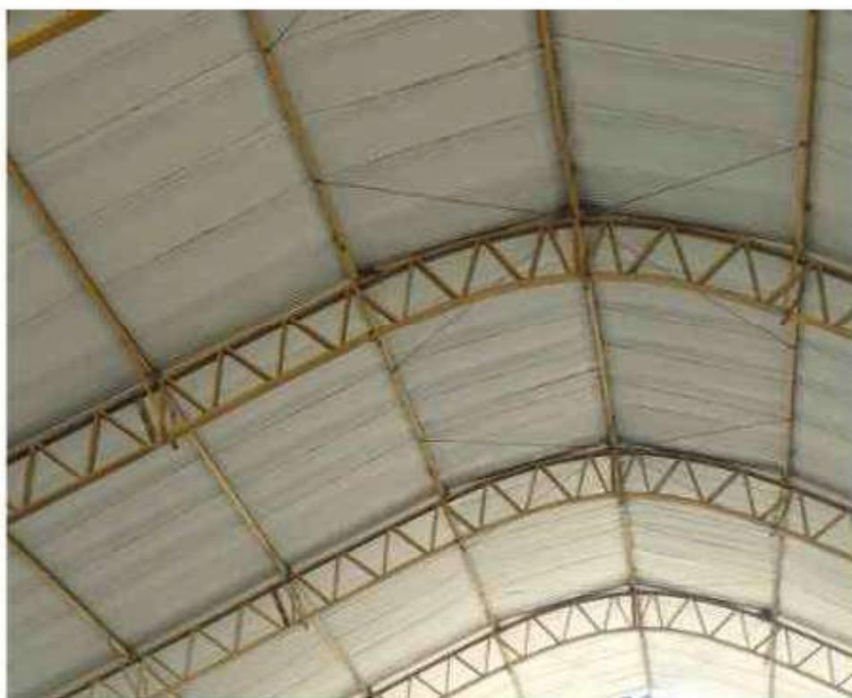
Figura 17 – Estrutura de cobertura e telhamento metálico da quadra.
