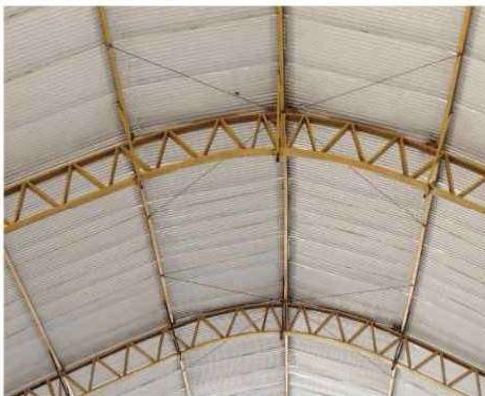
Figura 19 – Estrutura e telhamento metálico da quadra
