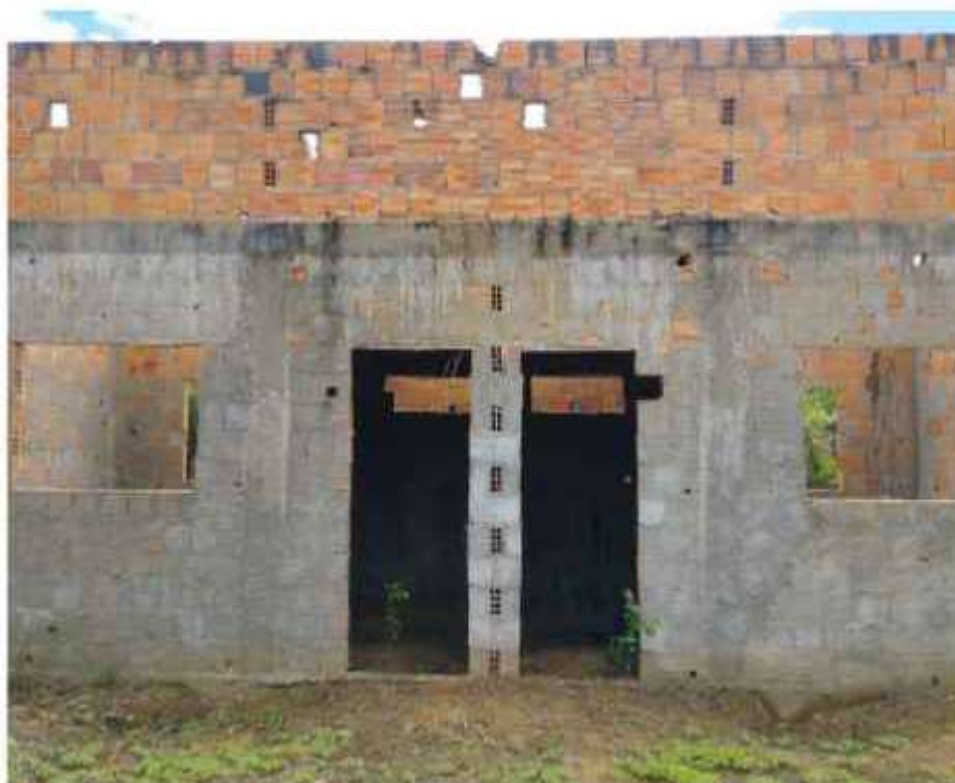
Figura 20 – Sanitários executados – vedações, superestrutura e laje pré-moldada Fonte: elaboração própria. (20/05/2024)
