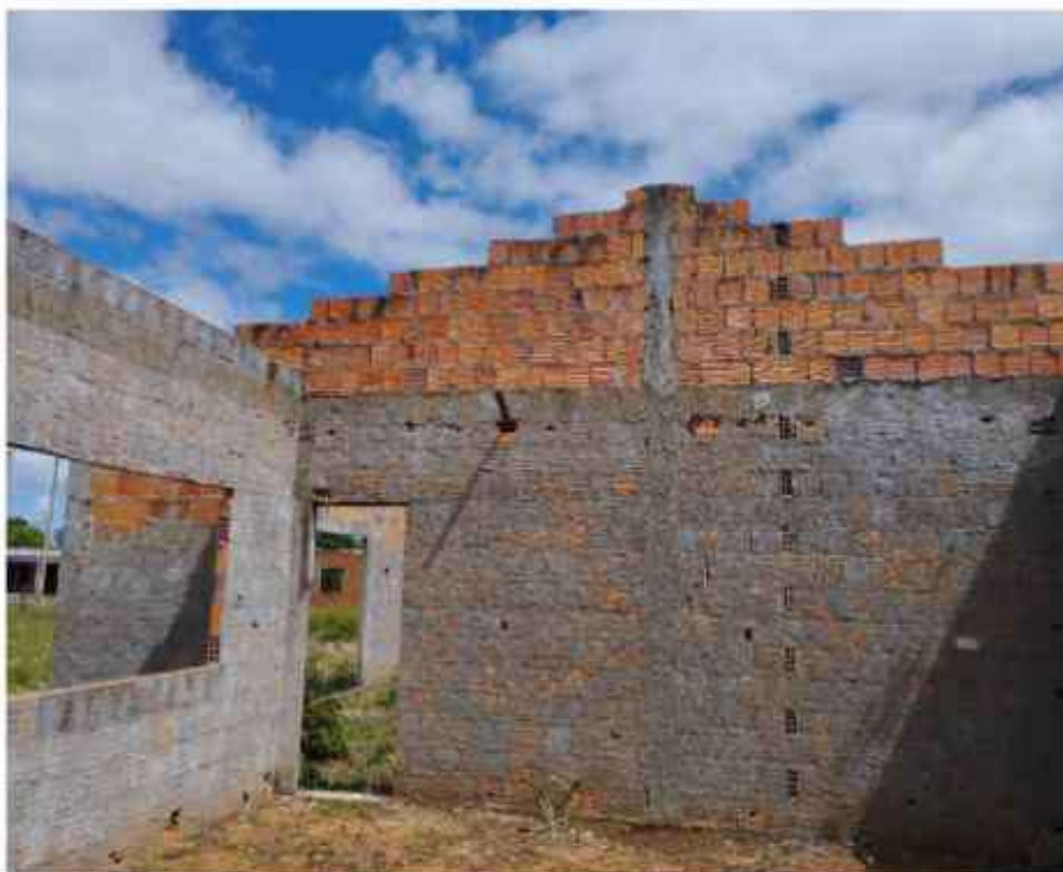
Figura 17 – Sala de aula B – Vedações e superestrutura executada.
