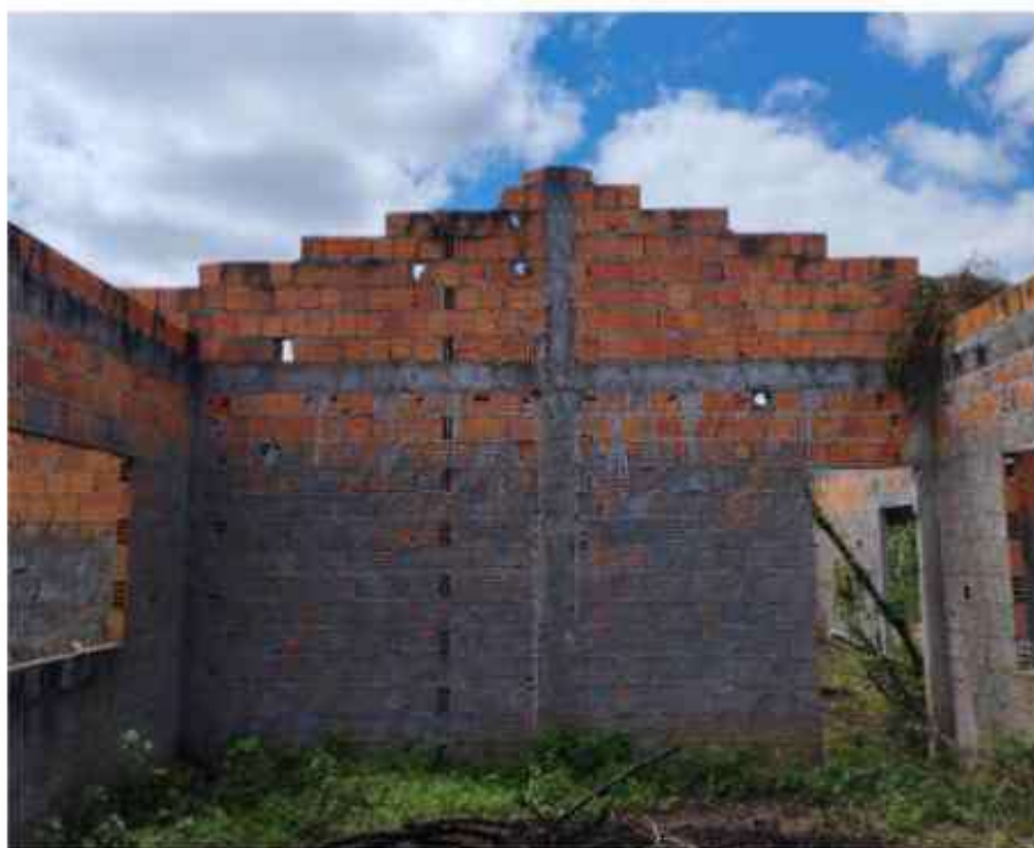
Figura 19 – Sala de aula A – Vedações e superestrutura executada Fonte: elaboração própria. (20/05/2024)
