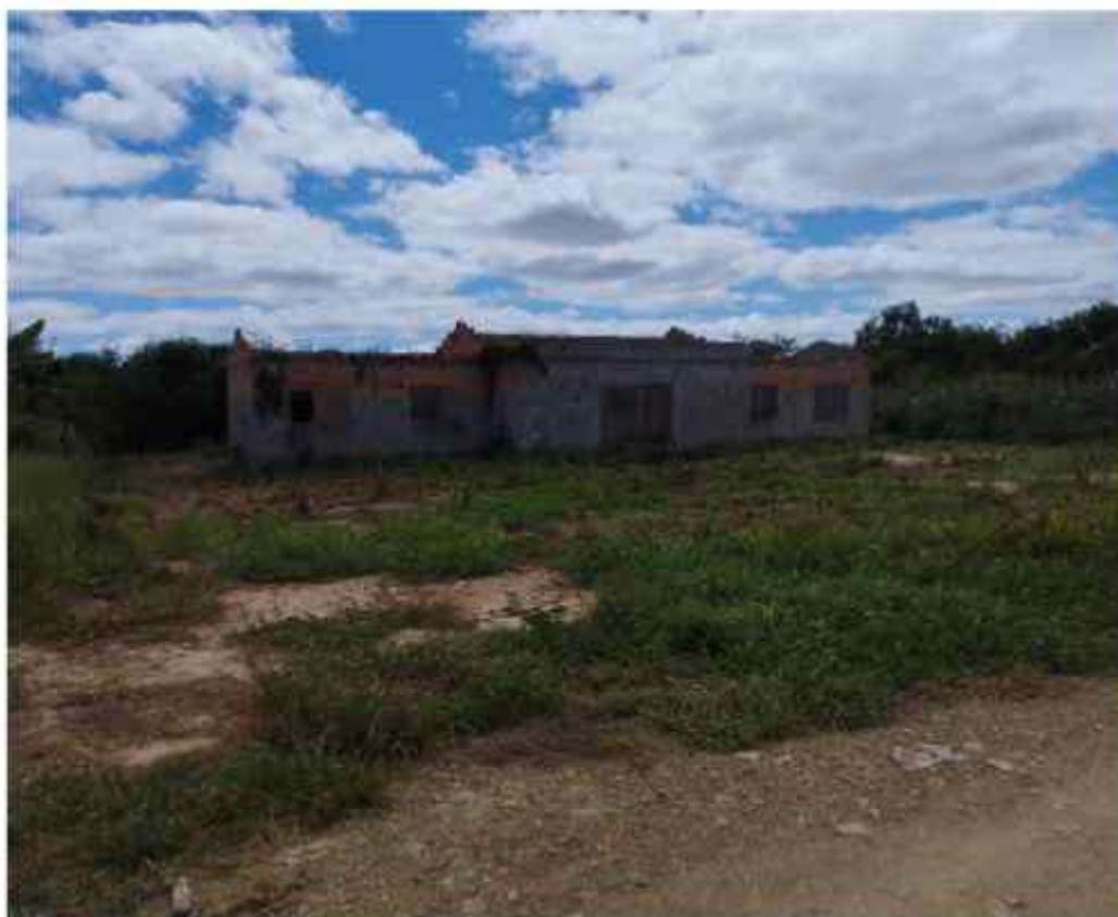
Figura 6 – Vista frontal da construção no lote (confrontantes).
