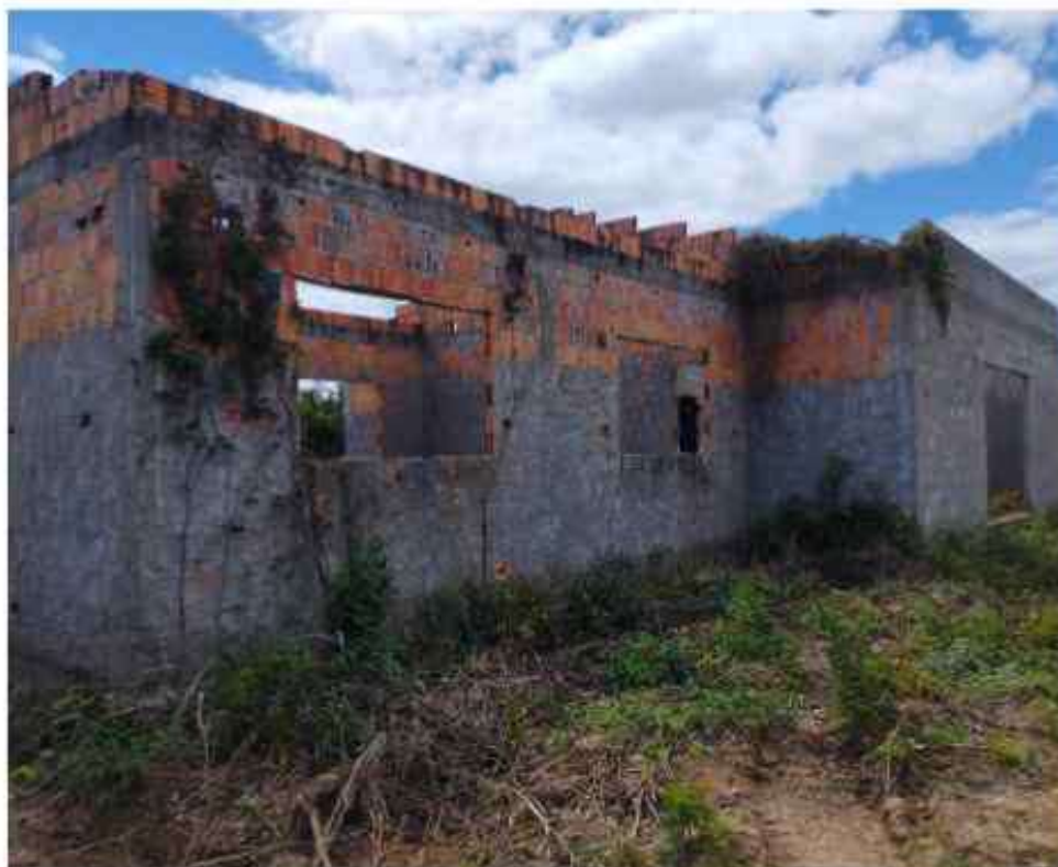
Figura 27 – Vista frontal da edificação
