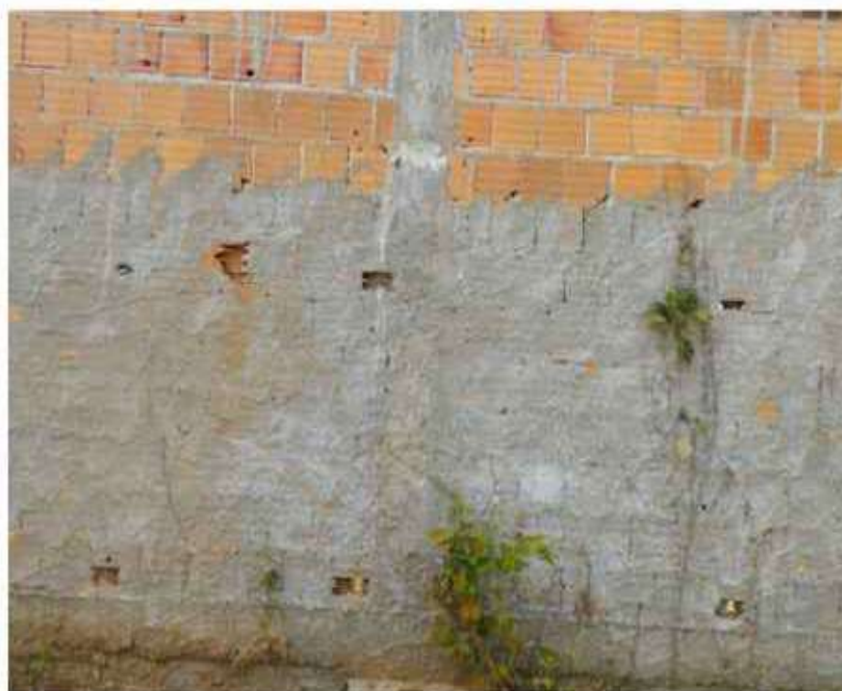
Figura 26 – Chapisco iniciado Fonte: elaboração própria. (20/05/2024)
