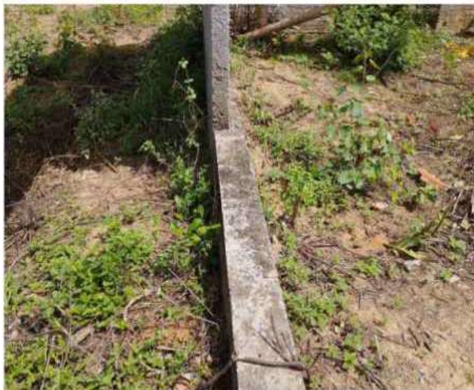
Figura 9 – Vista interna do lote – Serviços de infraestrutura executado – viga baldrame
