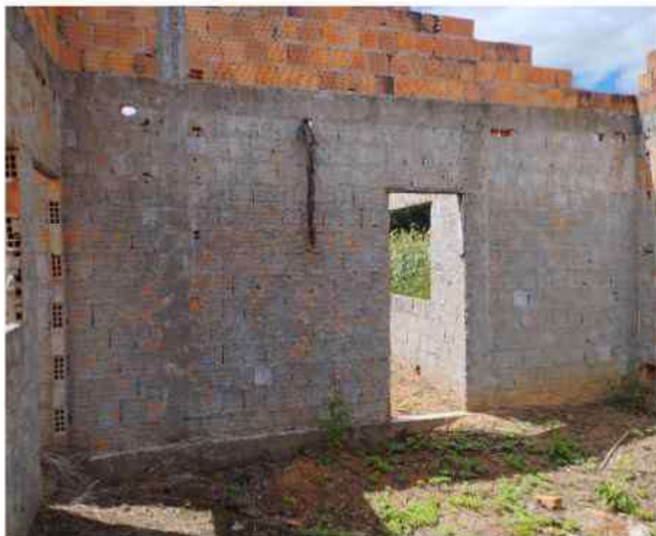
Figura 10 – Vista interna do lote – Serviços de superestrutura e vedações executadas
