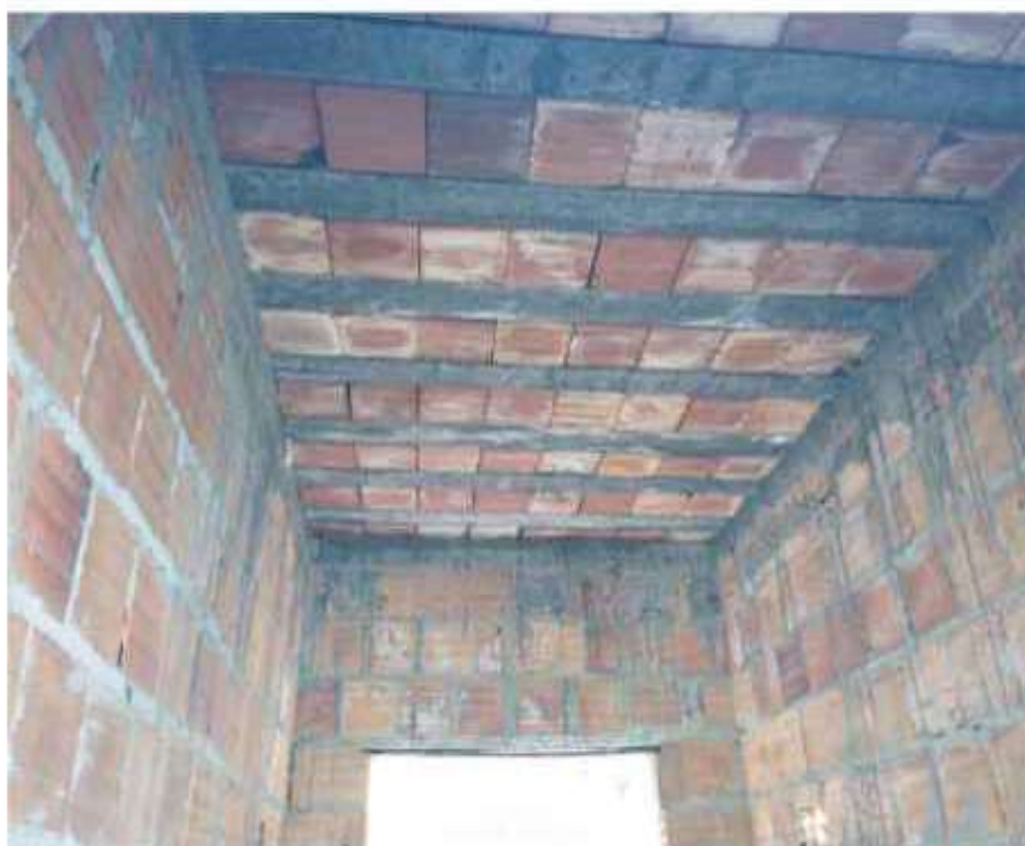
Figura 11 – Vista interna do lote – laje pré-moldada executada
