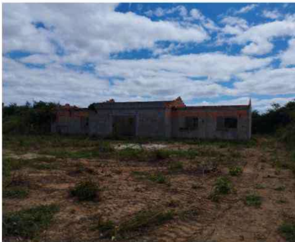
Figura 7 – Vista externa do lote – Obra sem serviços preliminares
