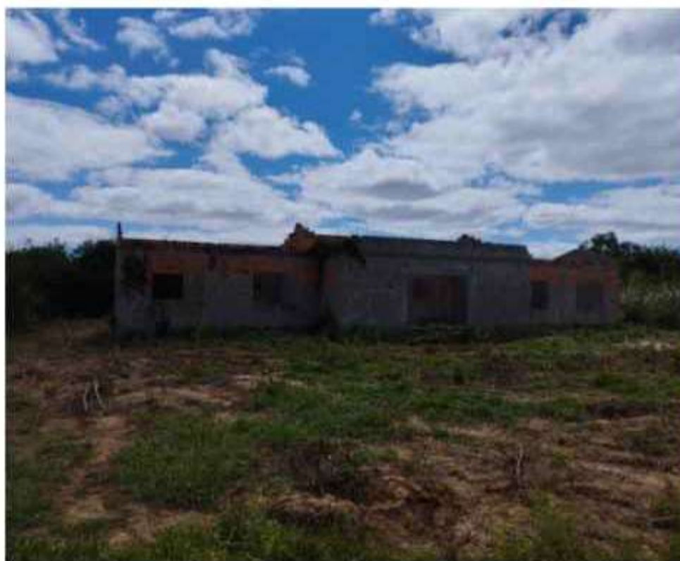
Figura 8 – Vista externa do lote – Obra sem serviços preliminares com vegetação rasteira na fachada posterior. Fonte: elaboração própria. (20/05/2024).
